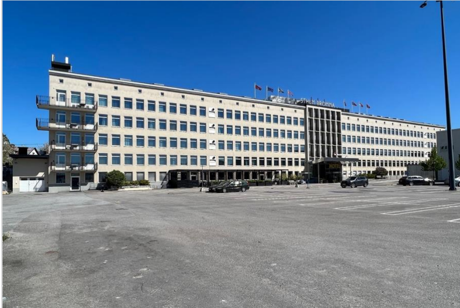
Kontorsbyggnaden sedd från gränsen mot tvärbanan i sydväst.
