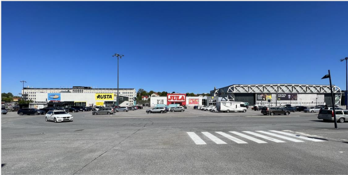
Vy från söder med kontorsbyggnaden på Trafikflyget 4 och 2004 års handelsbyggnad till vänster, den före detta huvudverkstaden i mitten (Jula) och en av flyghangarerna till höger.
