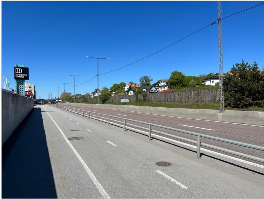
Ulvsundavägen med Trafikflyget 4 bakom skylten till vänster och villaområdet Mariehäll på andra sidan, i mitten och till höger i bild. Det höga planket längs Mariehäll är en konsekvens av problemen med buller och farligt gods på Ulvsundavägen.
