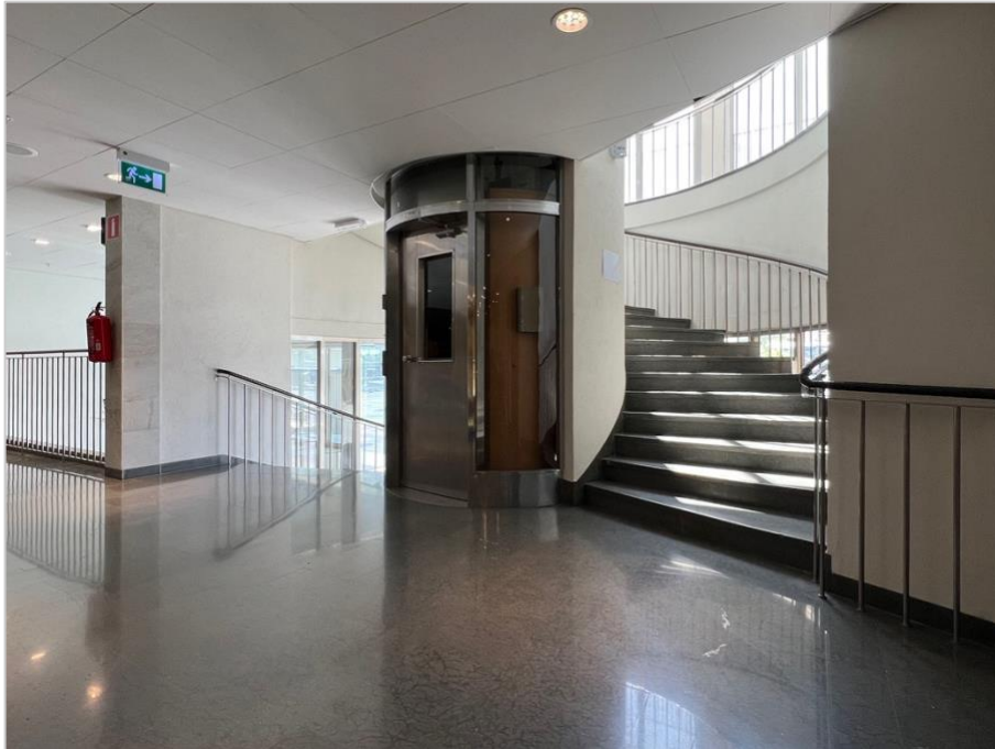
Trapphuset med sin runda trappa och hiss, glasade väggar, räcke av rostfritt stål och golv av kalksten är fortfarande välbevarat.
