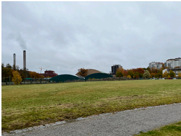
Grönyta med tennistälten och Kungl. Tennishallens tillbyggnad i fonden.
