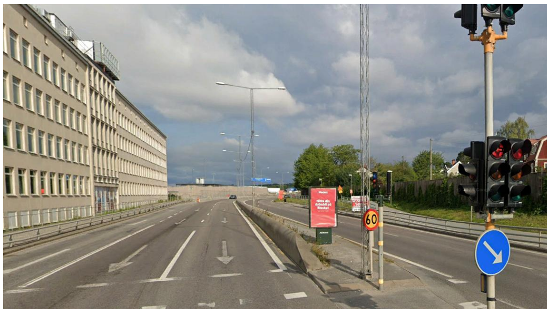
Figur 3.1. Ulvsundavägen sett söderifrån med fastigheten Trafikflyget 4 till vänster i bild.
