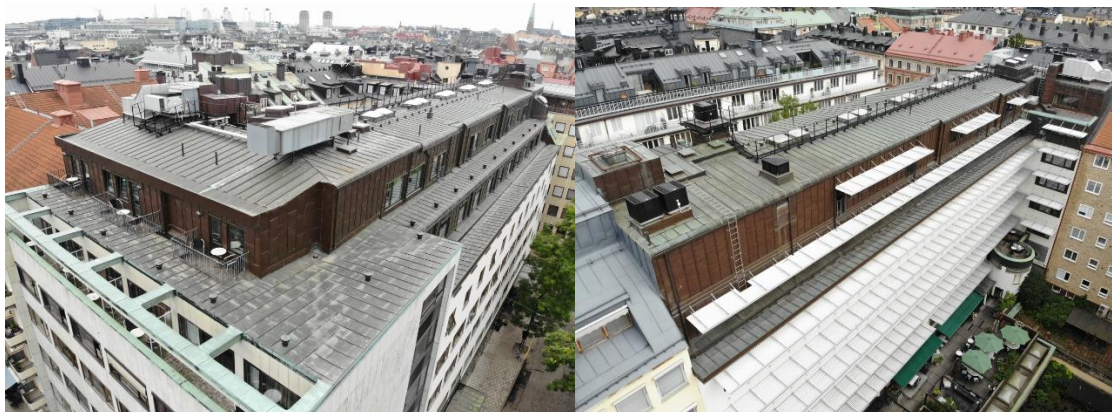
Figur 6. Drönbilder på befintligt koppartak och -fasad. Bild till vänster tagen i sydvästlig riktning, bild till höger tagen i nordöstlig riktning. Foto: Nyréns Arkitektkontor.
