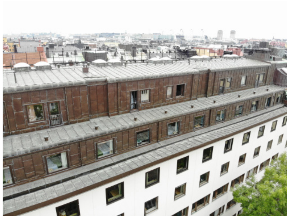
Befintlig takpåbyggnad med sin karaktäristiska koppar och rundade tak, på plan 6-7, i huvudsak tillkommet under 1980-tal.
