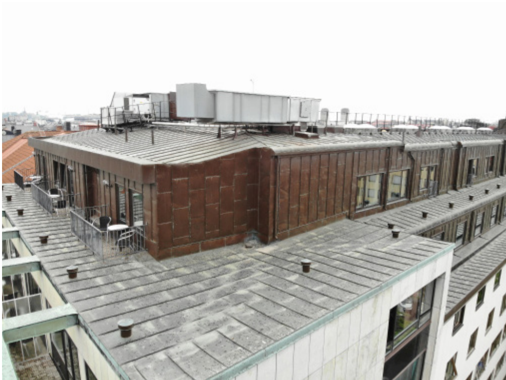
Befintlig takpåbyggnad med sin karaktäristiska koppar, på plan 7, i huvudsak tillkommet under 1980-tal, men här fanns en mindre påbyggnad på plan 7 redan ursprungligen men med mindre utsträckning mot väst.
