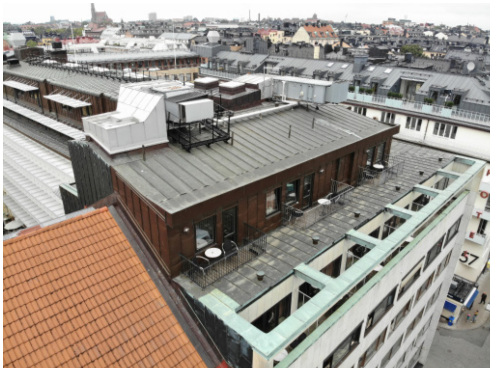
Befintlig takpåbyggnad mot Nybrogatan, med sin karaktäristiska koppar, i huvudsak tillkommet under 1980-tal. Den grön-ärgade kopparen troligen ursprunglig.
