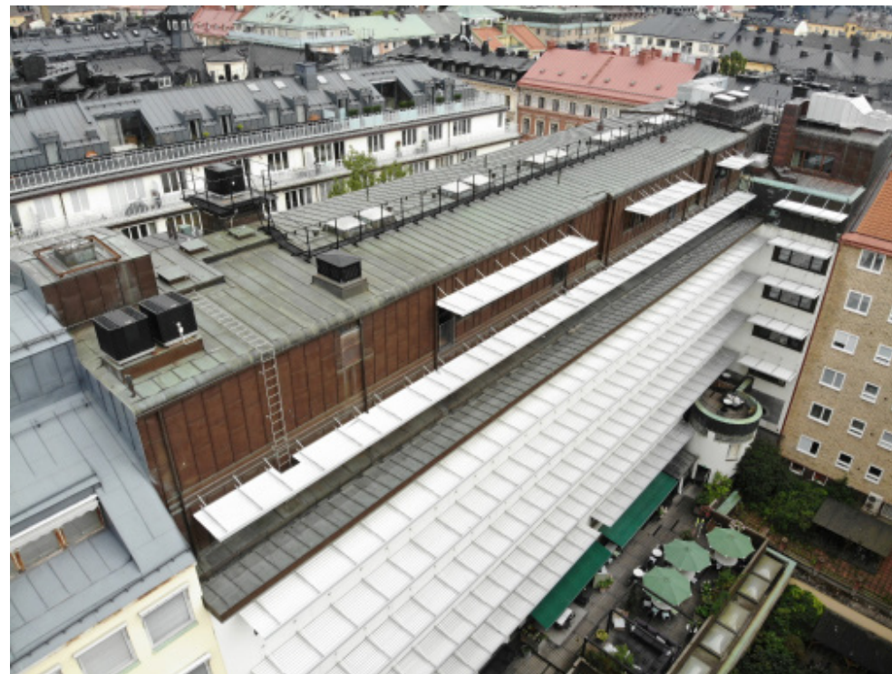
Flygvy över södra fasaden. Befintlig takpåbyggnad med sin karaktäristiska koppar, på plan 6-7, i huvudsak tillkommet under 1980-tal.
