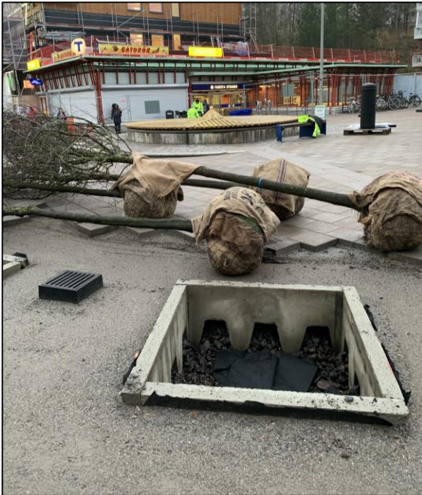
Figur 9.9. Anläggning av trädplantering i skeletttjord. Källa: NIRAS
