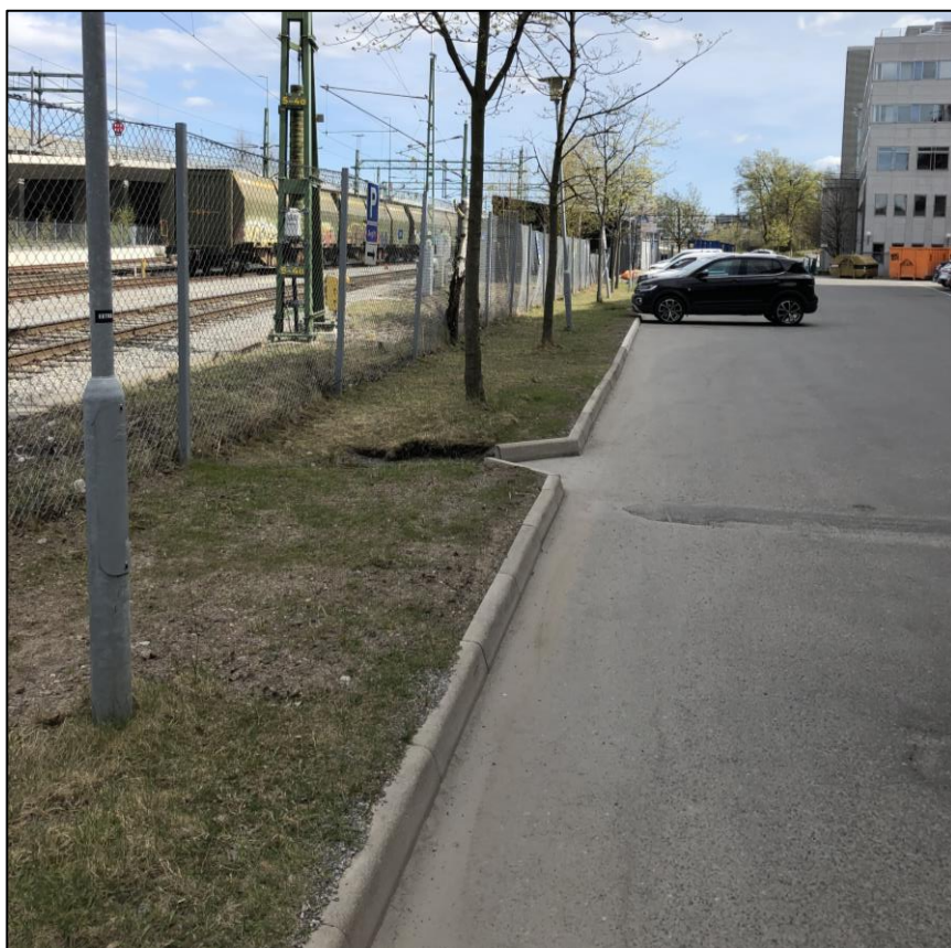
Figur 8.2. Kantsten mellan Bremen 1 och Bremen 3 mot rangerbangården. Bildkälla: NIRAS
