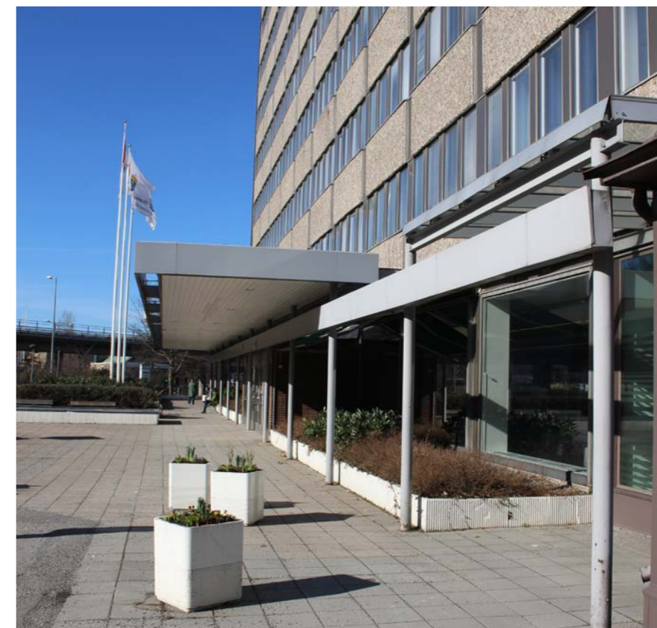
Entréparti mot Tegelluddsvägen. Närmast fasad finns låga planteringskar vilka utgör en del av 1960-talets markgestaltning samt ett långt skärmtak som är utbytt och delvis ändrat i samband med att förvaltningsrätten flyttade in.
