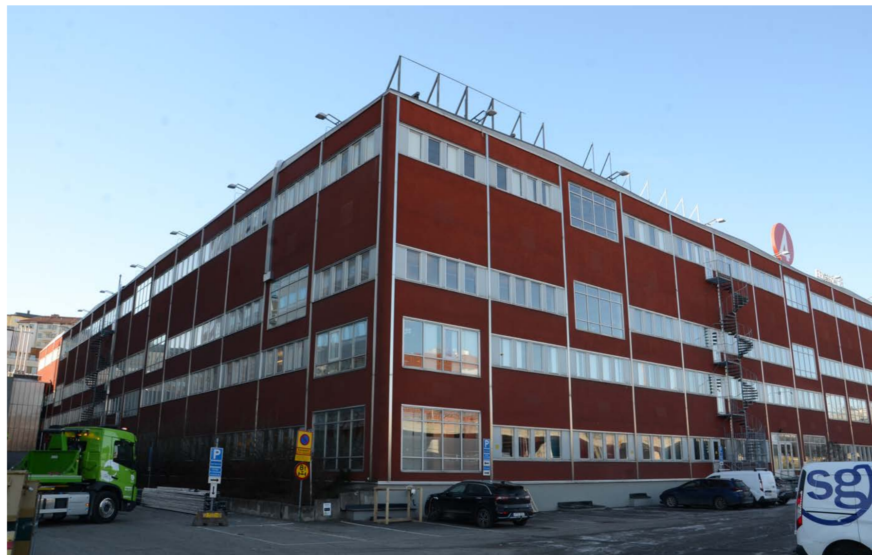
Byggnadens östra och norra fasader. Från detta håll framstår byggnadens omfattande volym och ytor tydligt. De större högre fönstren som tillkom i samband med 1990-talets ombyggnad bryter upp de horisontella fönsterbanden, oregelbundet.
