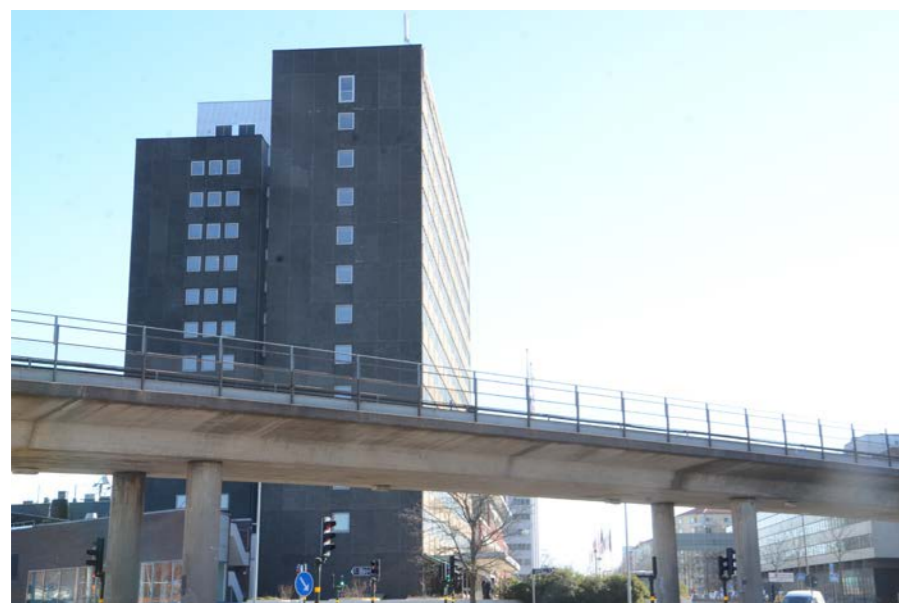
Tunnelbanan går på bro ut från stationen i berget. I bakgrunden Bremen 3.
