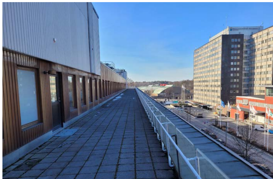
Längs hela det 120 m långa låghuset löper en bred, till största delen norrvänd takterrass, helt täckt av betongplattor.
