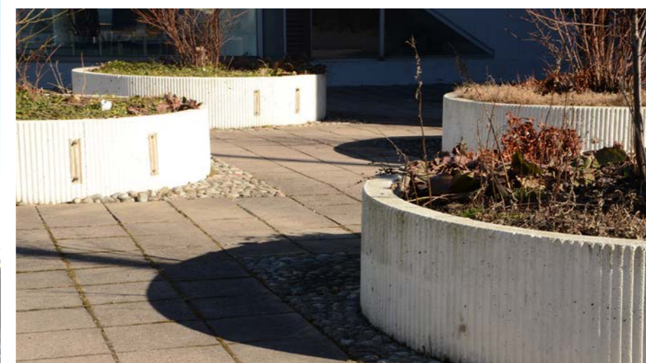
Planteringskar intill byggnadens västra gavel. I betongen syns spår av hur karen tidigare varit sammanbundna med varandra.
