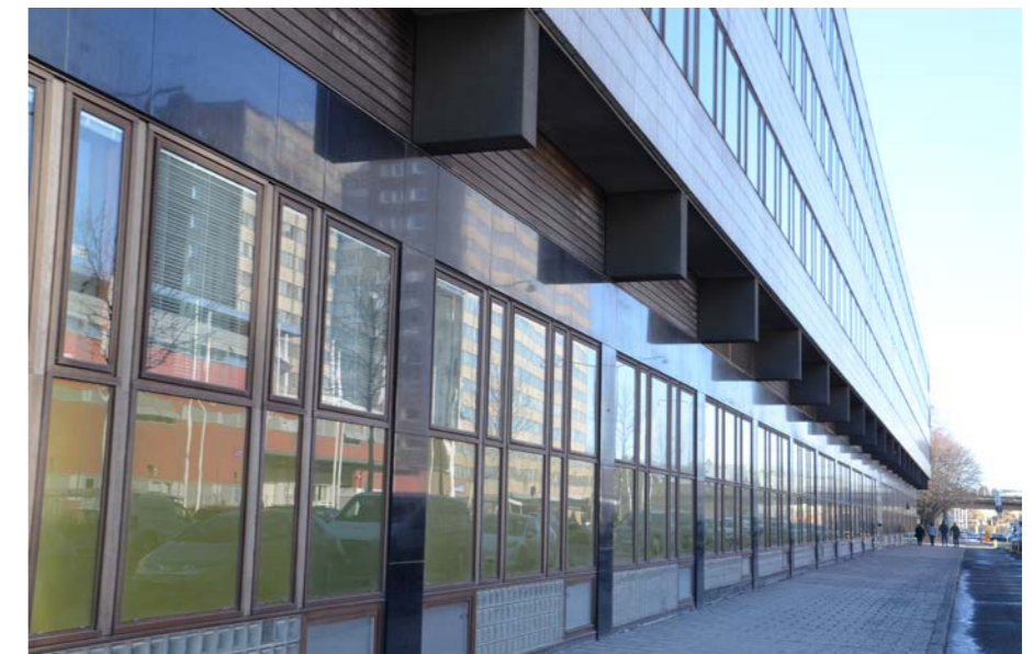
Låghuset har en tydligt markerad, indragen bottenvåning mot Tegeluddsvägen. Den har en karaktär som tydligt avviker från fasaderna ovan. Att förse övre källarplanet med ljus har varit överordnat att skapa en god kontakt med gatan. Bjälklaget ligger flera decimeter över gångbanans nivå och har dolts bakom aluminiumpartier och färgat glas.
