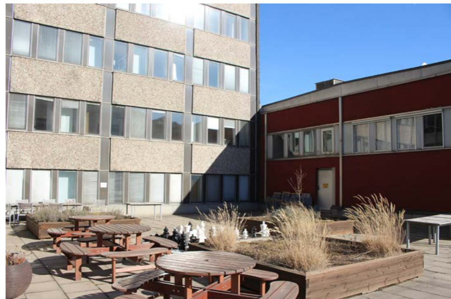
Terrass i solläge mot Tegelluddsvägen och angränsande till Bremen 1. Planteringskar och möbler är inte ursprungliga. Många delar av de stora terrassytorna saknar möblering och används sparsamt.
