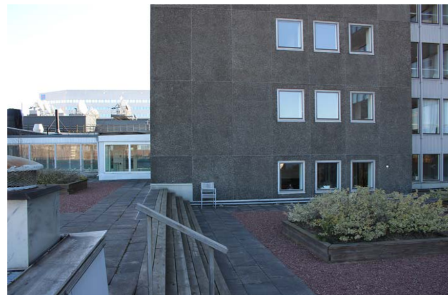
Byggnaden har tre terrasser på plan 5. Terrassen i väster mot Lidingövägen ligger i två nivåer. Mellan höghusdelen och den övre plåtbeklädda delen av lågdelen går en glasad passage vilken ursprungligen ledde till mindre matsalar och sällskapsrum, idag till sessionssalar och väntrum. Runda planteringskar är ersatta av planteringskar i trä.
