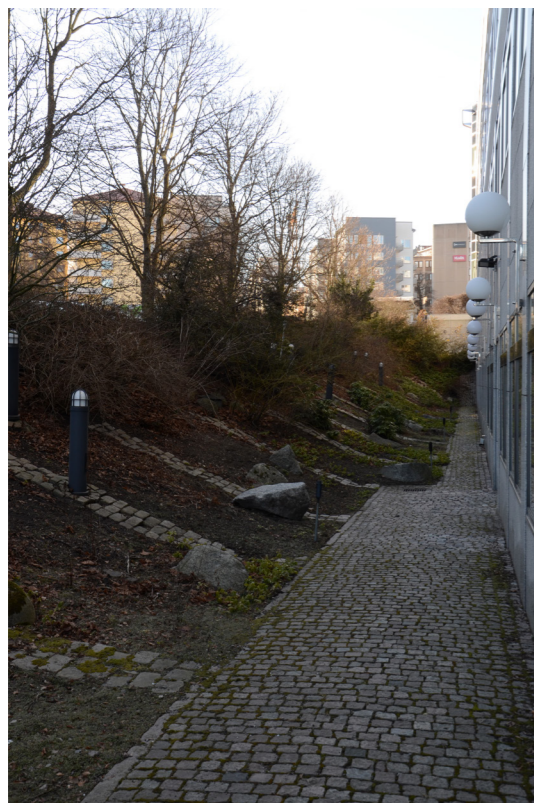
Östra fasaden med intilliggande planteringar. Klotlamporna i fasaden är ursprungliga och förekommer i olika utformning runt om fasaden. Planteringen intill östra fasaden har en välgestaltad utformning som visar på en omsorg om utemiljön.
