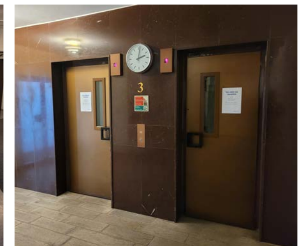
Hisshall i låghusets västra del, Handelsbankens del. Utformningen är starkt tidstypisk, under 1960-talet hade natursten en stark ställning i miljöer som dessa. Hisshallar och trapphus är välbevarade.
