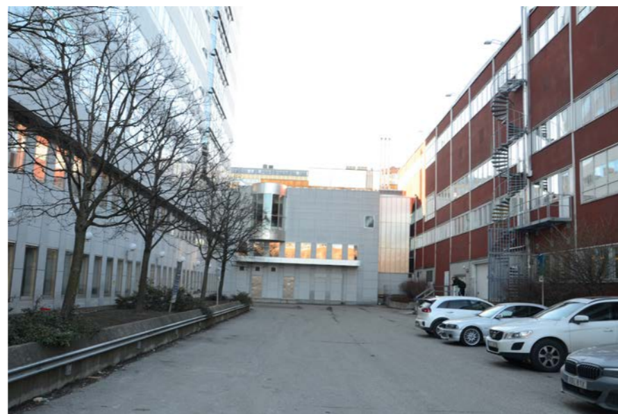
Här syns östra fasaden av Bremen 1 vilken angränsar till Bremen 2 med en lägre hörsalsbyggnad. Båda fastigheterna är byggda med suterrängplan och Bremen 1 har två våningsplan (tre med takuppbbyggnad) mot Tegeluddsvägen och fyra i övriga fasader.
