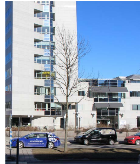
Huvudentrén som är placerad i mötet mellan höghus del och låghusdel markeras med ett glasat burspråk i tre våningsplan. Styrelserum och sammanträdesrum placerades rakt ovan entrén med stora ljusinsläpp genom de glasade burspråken. Möjligheten att köra ända fram till entrén har funnits från byggnaden uppfördes.
