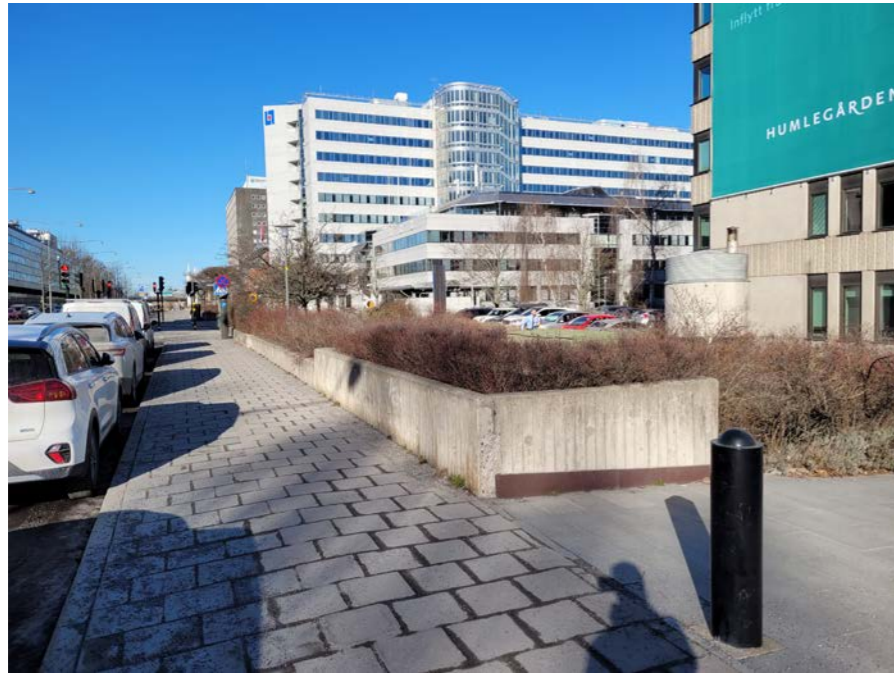
Förgårdsmark vid Tegeluddsvägen. Ursprungliga planteringsytor avgränsade med betongmurar. I buskagen finns avluftrör från underliggande garage. Förgårdsmarken med planteringar skapar tillsammans med intilliggande fastigheters förgårdsmark ett grönt stråk och en tydlig avgränsning mot Tegeluddsvägen.
