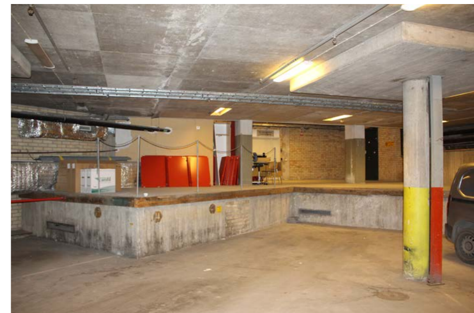
De nedre våningsplanens parkerings- och lastytor är relativt oförändrade sedan byggtiden. Betong och gult tegel är karaktäristiskt för ytor som dessa under 1960-talet. Här en bild över lastintag på plan 1 som har kvar sin funktion.
