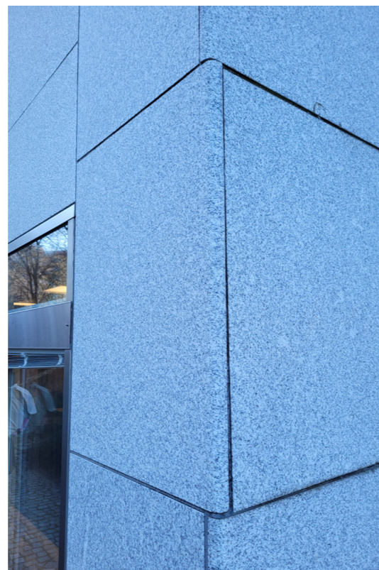
Detaljer utförda med omsorg, ett utvändigt hörn med förskjutna fogar.
