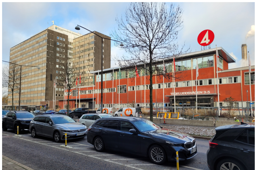
Figur 7 – Foto från Tegeluddsvägen, Tyréns.
