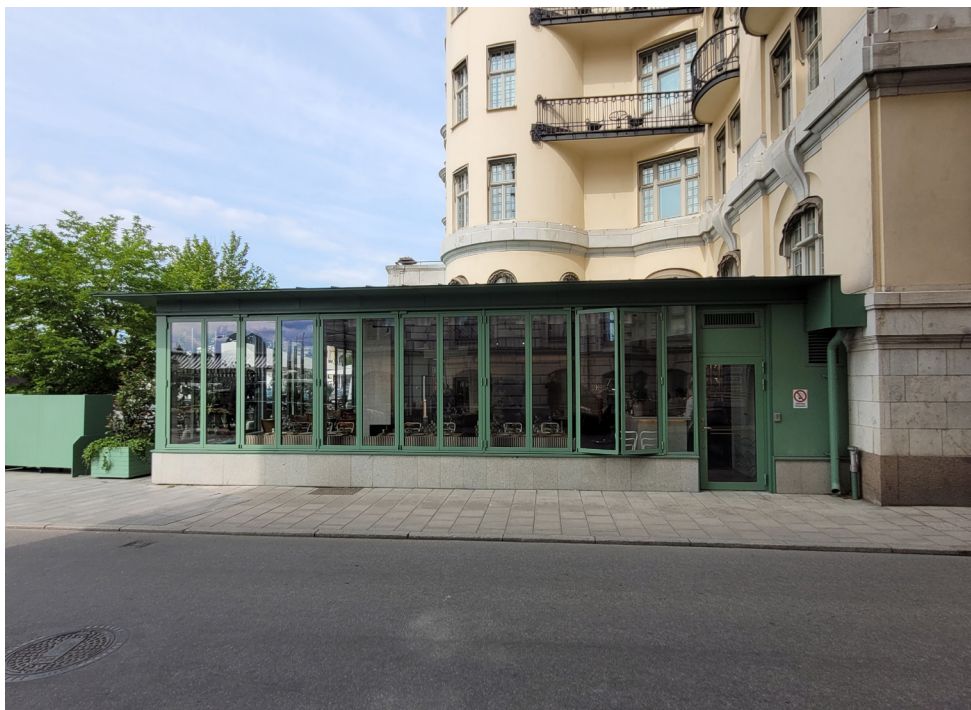
I den södra paviljongens sydöstra fasad har en utrymningsdörr lagts till närmast Burmanska huset. Taket viker ner för att hålla undan för fönster i bottenvåningen.
