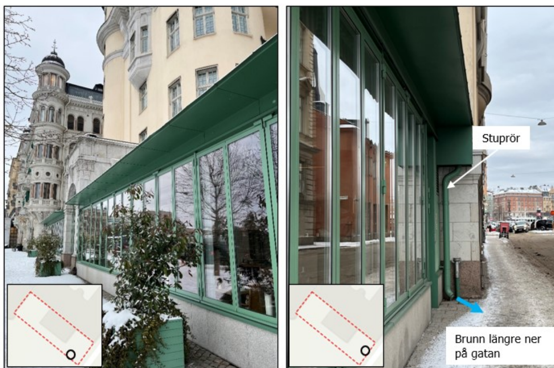
Figur 2. Vänstra bilden visar paviljongens utseende och den högra bilden visar hur vatten från paviljongtaket avleds genom ett stuprör med utkast mot gata. De mindre bilderna visas även var fotot är taget (svart ring) i förhållande till planområdet.
