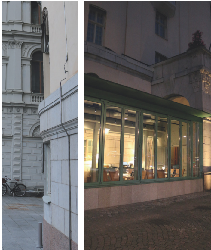
Foto: Ljusdesign av sockelfasad
