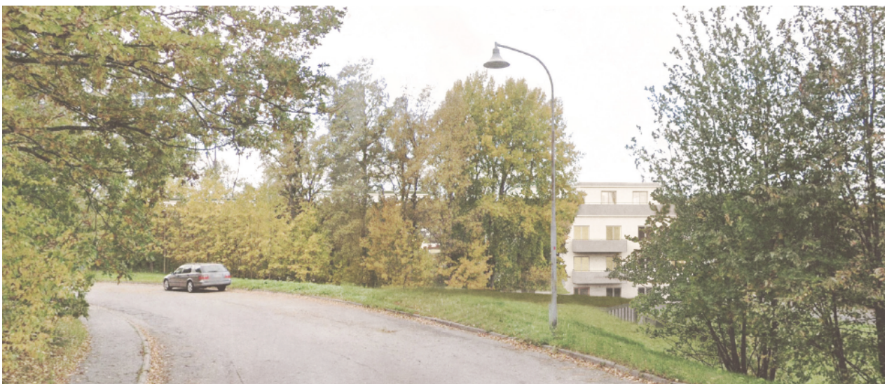
Carport med grönt tak som är underordnad marknivå på Asplövsgränd.
