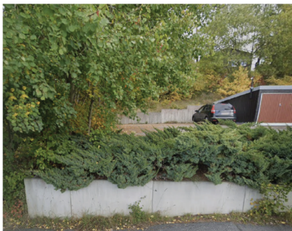
Stödmur med plantering framför markparkering vid Blomkronegränd
