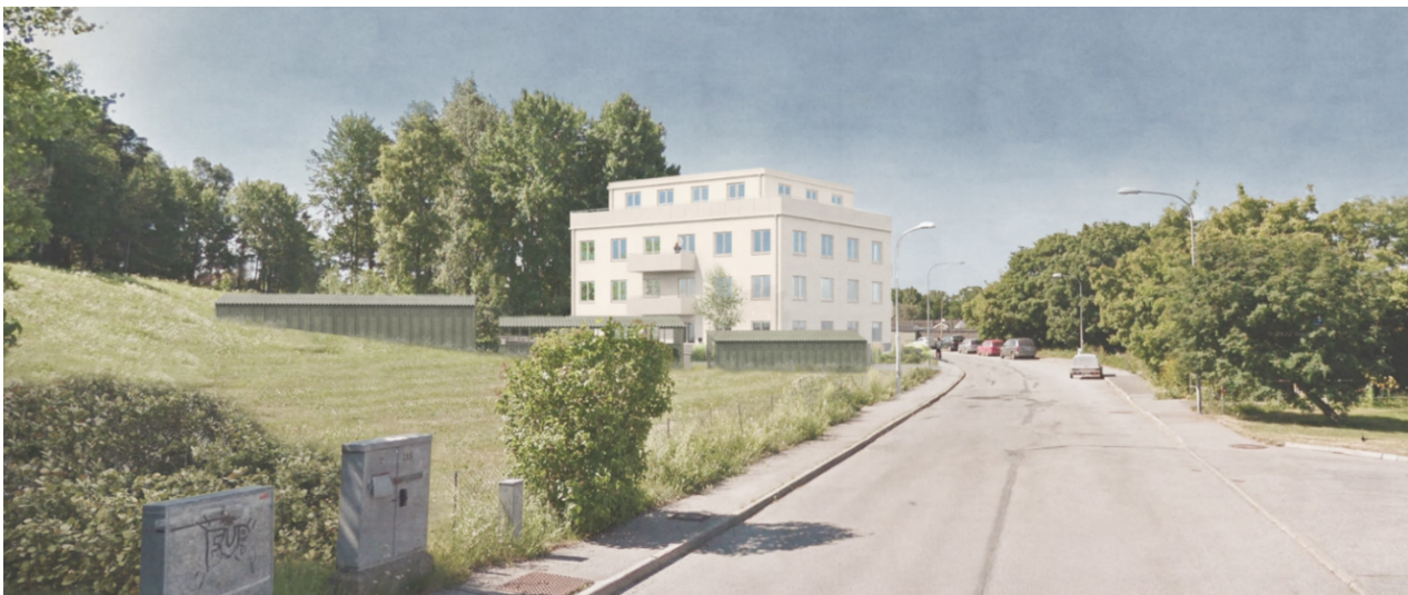
Sammanbyggda komplementbyggnader mot park som trappar ner mot Backlöksvägen.
