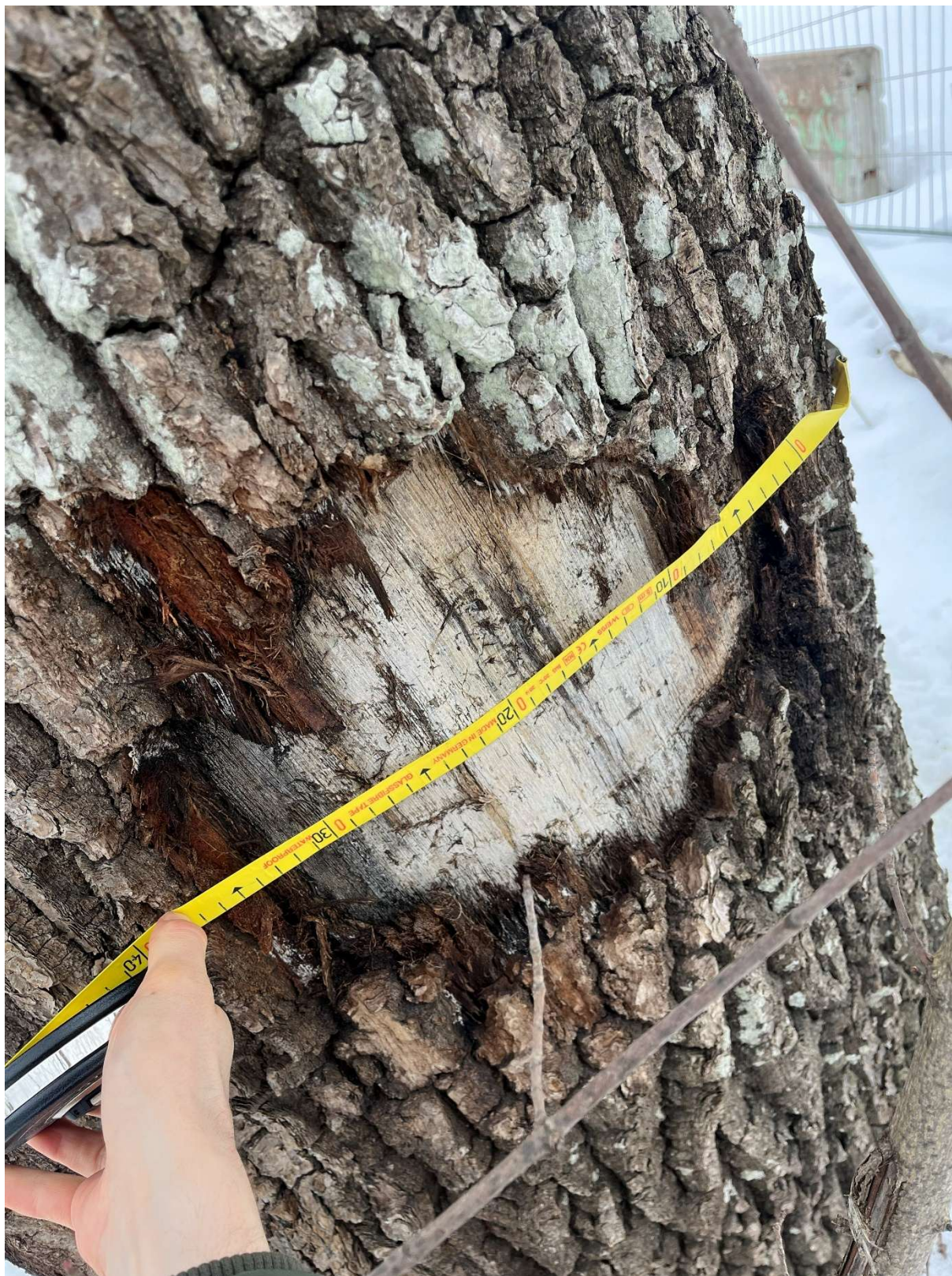
Figur 6. Mekanisk skada på stam.
