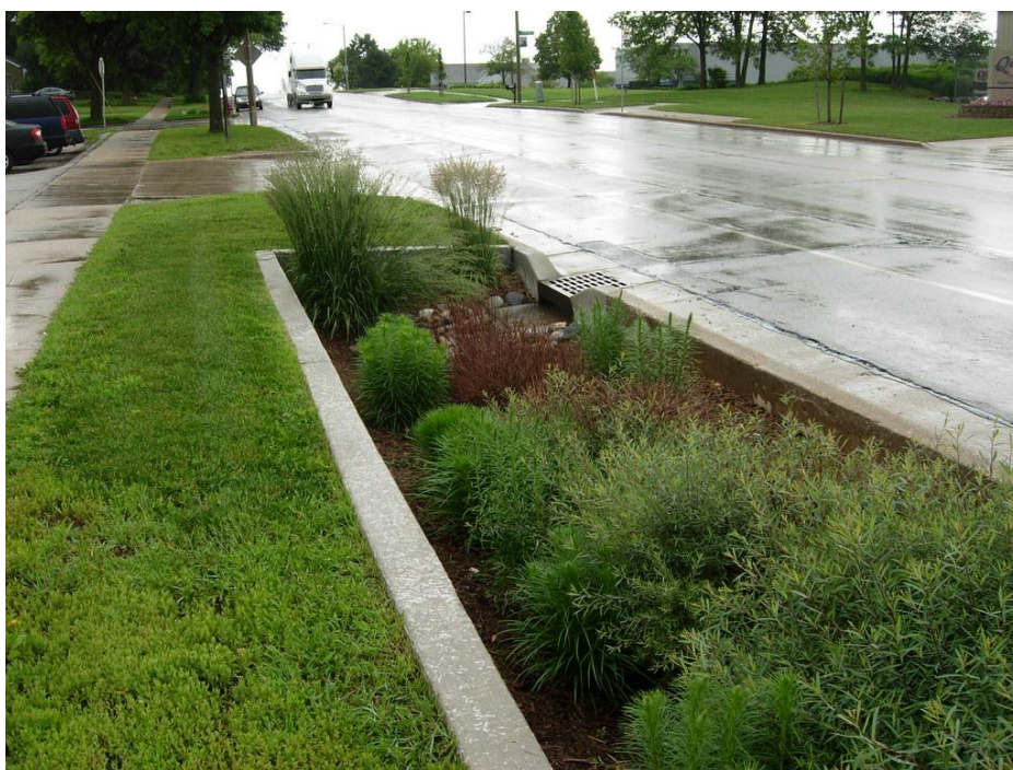
Figur 16. Exempel på nedsänkt regnväxtbädd längs gata.
