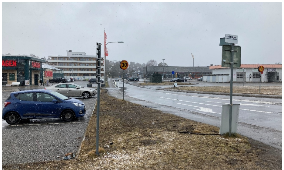
Lövkojsgränd. Vy från Lövstavägen. Befintlig trädgårdshandel inom planområdet till vänster i bild. Åkermymntan C och tankstation till höger i bild. Foto: SBK.
