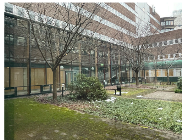
SRA:s innergård med 1990-talets förbindelsegång.
