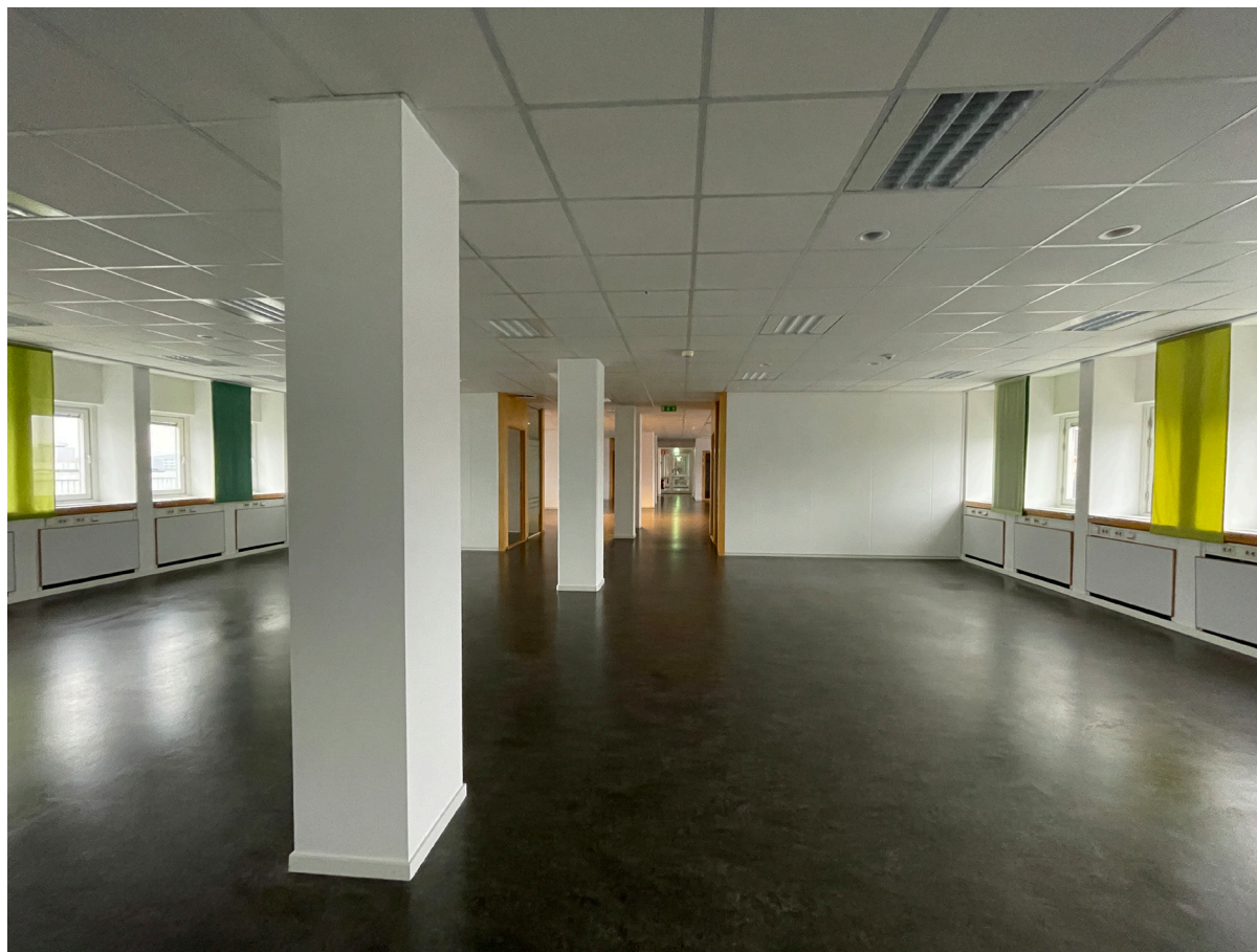
Kontorsvåning med bärande kvadratsika pelare i en av SRA:s lågdelar.
