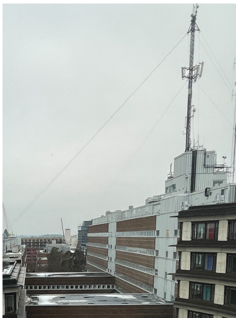
SRA:s taklandskap med sin karaktäristiska teknikvåning i plåt som binder ihop teknikvåningen med trapphusens plåtfasader
