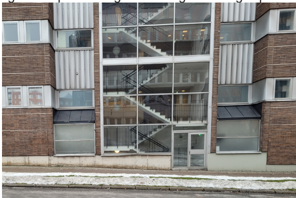
Den glasade trapphusfasaden möte mark med en liten sockel. Det synliga trapploppet accentuerar vertikalteten. fasadens direkta möte med mark är karaktäristiskt för både tiden och byggnadens funktion som kontor.
