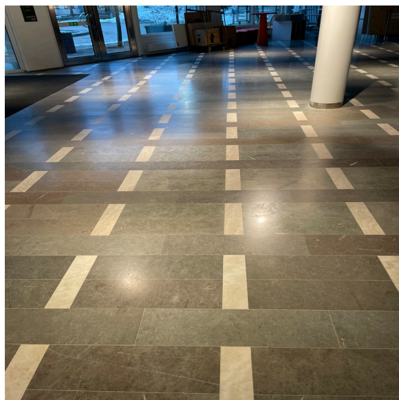
Kalkstensgolvet i entré-/receptionsytan i ERA:s bottenvåning har stora kvaliteter och är identifierat som en värdebärande yta.
