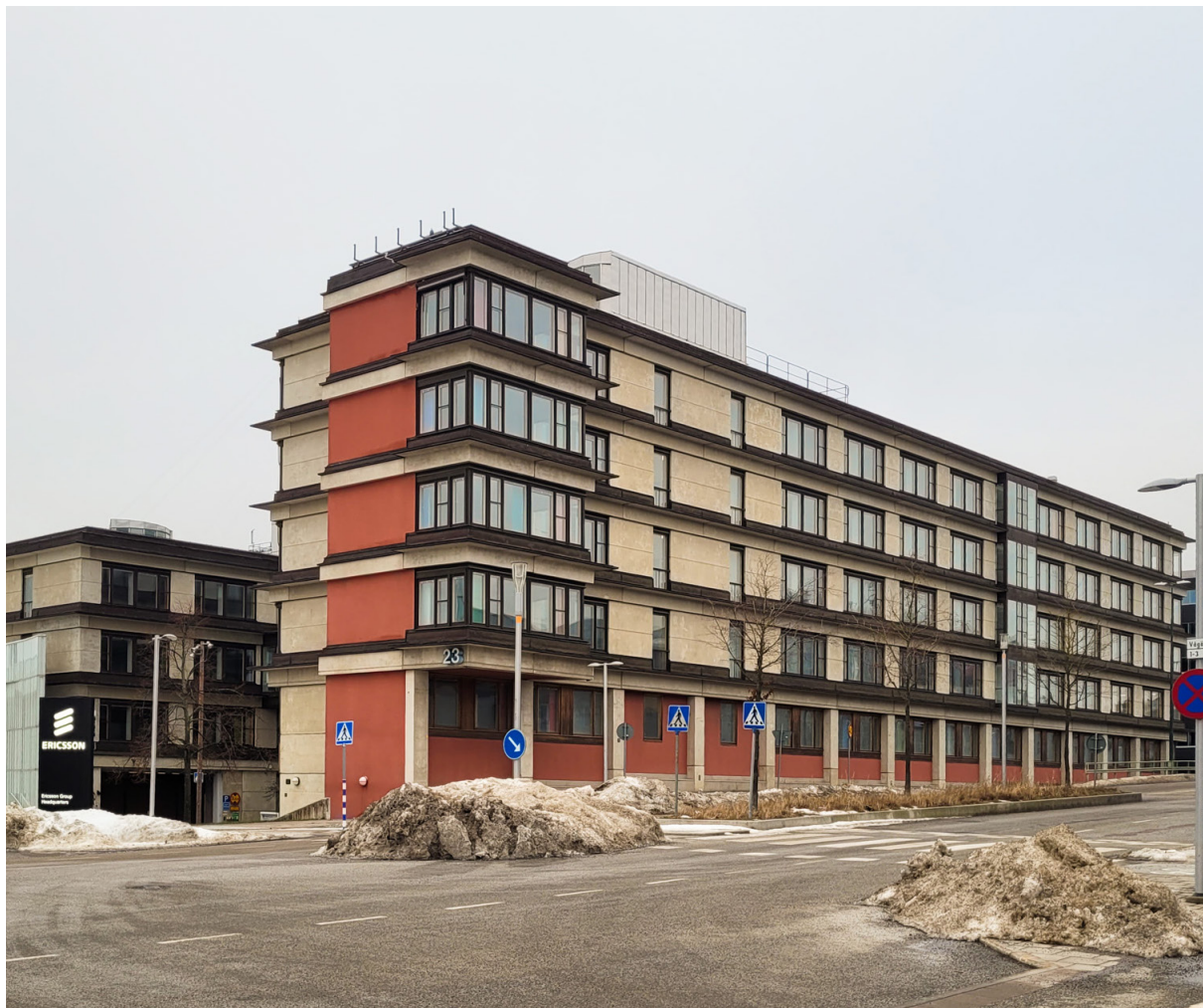
ERA:s fasad mot Torshamnsgatan med sin representativa och stadsmässiga fasadutformning och karaktäristiska materialkombination. Till vänster det lägre gårdshuset.
