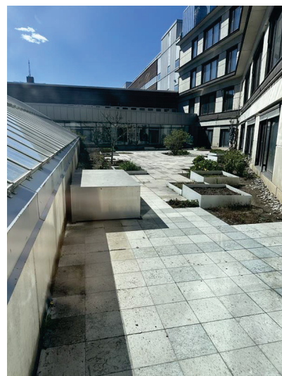
Figur 14. Gård F enligt platsbesök. Bilden tagen från nordöst mot sydväst och påstådd nedsänkning av gården hade synts närmast i bild.
