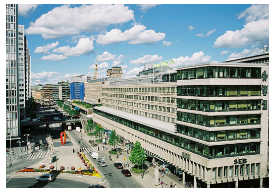
S-huset efter om-, till- och påbyggnad. Foto: Göran Fredriksson 2007, SSM.
