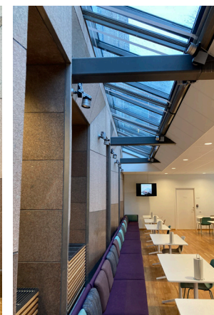
Tidigare fönsteröppningar har naturstensklädda nischer. Fönstren har avlägsnats men muröppningarna finns kvar.
