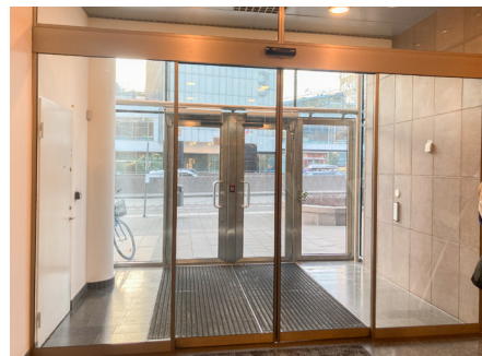
Den nedre entréhallen med golv och ny trappa i mörk kalksten och entrépartier i glas och rostfritt stål.
