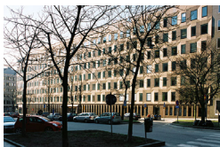
3. Putten 15, Göteborgs Bank 1964-1967, Ark Anders Tengbom. Foto: Göran Fredriksson SSM.
