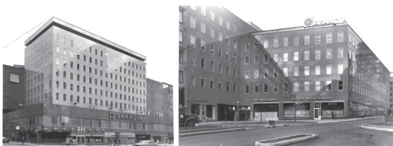
Putten 16 före på- och tillbyggnader. Foto: SSM 1975.
