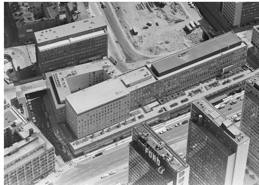
Kv Putten mot Sveavägen med Putten 16 till vänster och Putten 15 till höger i bild. På fotot syns kvarterets sammanhängande terrassplan. Foto: Erik Claesson 1972, RAÄ.
