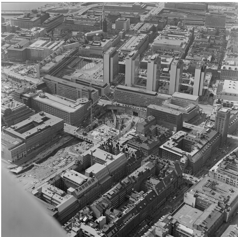
Pågående tunnelbyggande under kv Grävlingen. Omgivande bebyggelse i kv Hästskon, kv Putten och fastigheten Hammaren 14 längs Malmskillnadsgatan är färdigställd och inflyttad. Övriga delar av kv Hammaren har ännu inte rivits. Foto: Erik Claesson 1973, Riksantikvarieämbetet.
