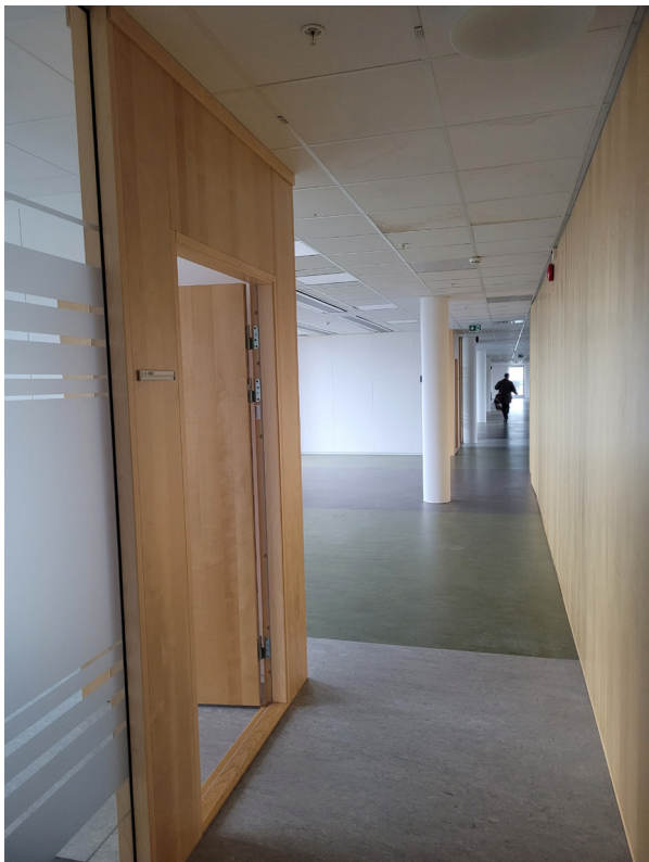
Figur 84. Kontorsutrymmen med portaler av trä och glaspartier, sannolikt från 2003-års ombyggnad. Linoleumgolven är sekundärt tillkomna, sannolikt i anslutning till att moderbolagets huvudkontor flyttade in.
