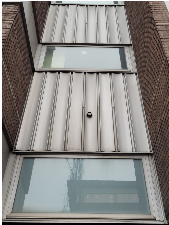
Figur 28. Aluminiumplåt och perspektivfönster vid sidan av glasat trapphus. Plåtens kraftiga profilering bidrar till trapphusens höjdverkan.
