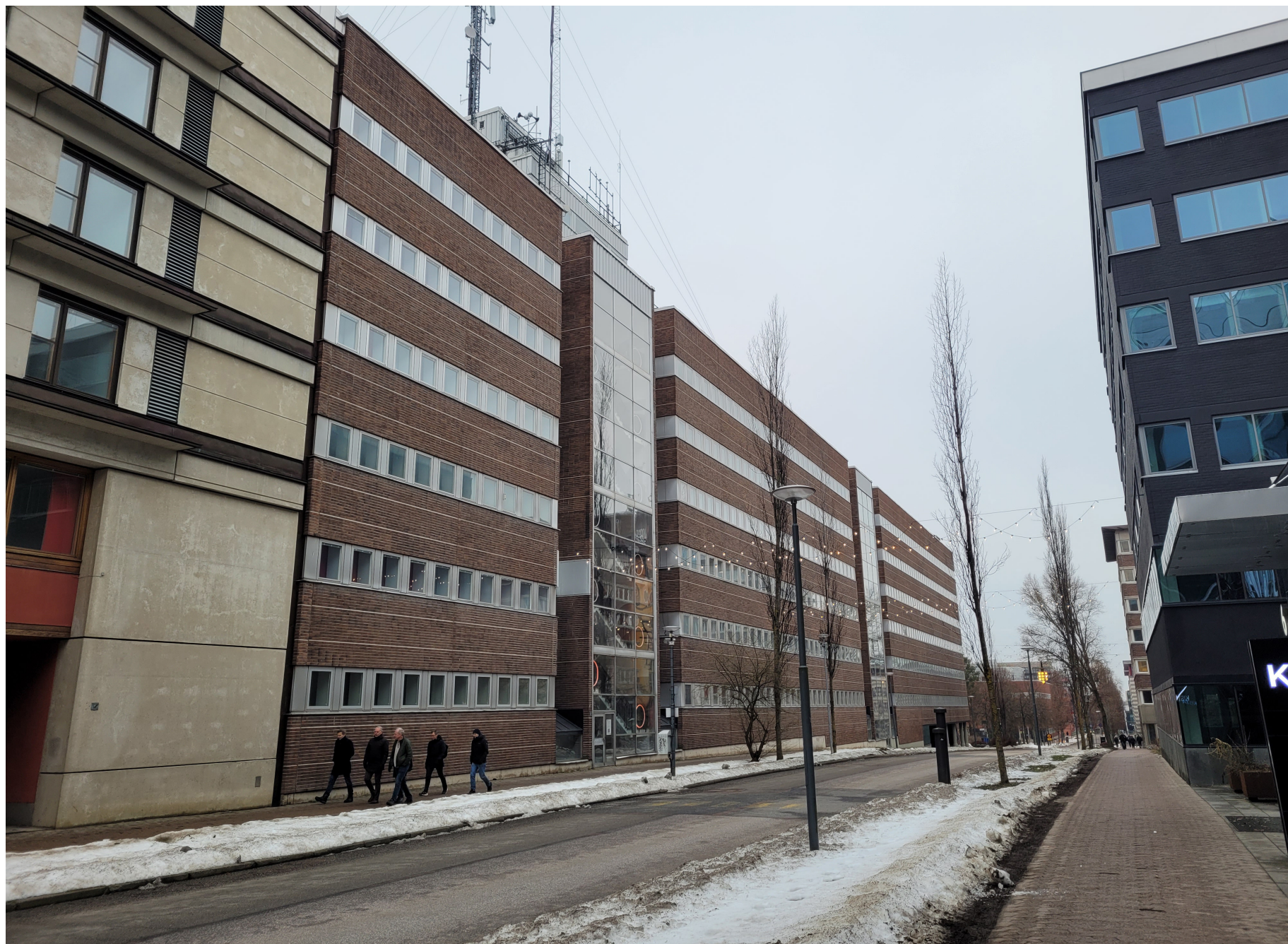
Figur 23. Fasaden längs med Kistagången med de två glasade trapphusen som bryter upp den långa fasaden i kvartersstora längder. Fasaden utmärks av en horisontell prägel med en tydlig randverkan vilket kontrasteras mot den vertikala glasade trapphusen som lyser upp gatan vid de mörka tiderna på dygnet och året. Också fönsterbanden bidrar till gatans ljussättning. Fasaderna är med undantag av trapphusen förhållandevis slutna genom stora och mörka tegelpartier. Bilden visar också mötet mellan SRA:s kontorsbyggnad och det nya huvudkontoret från 1990-talet. En kontrastverkan uppstår mellan de två byggnaderna som skiljer sig från varandra ifråga om uttryck och särskilt materialval. Det nya huvudkontoret fick en anpassad bjälklagshöjd i förhållande till den befintliga.
