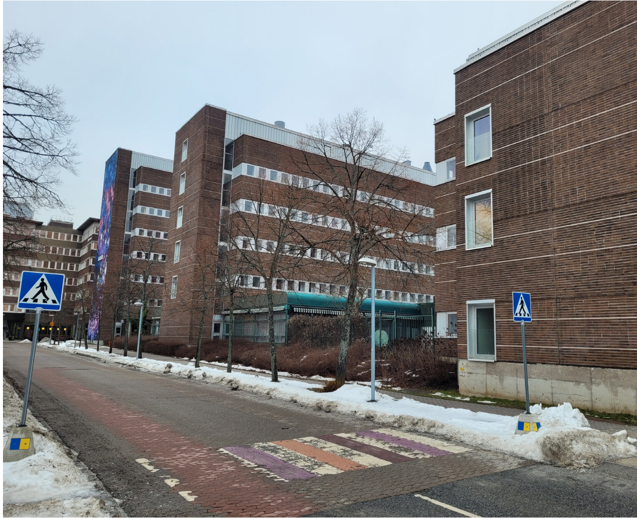
Figur 44. Byggnadskomplexet sett från Grönlandsgatan. Här syns tydligt hur volymerna blir lägre åt öst och hur trapphusen är definierade som egna volymer med murverkan, som en tjock skiva. Gavelvolymen är åtskild från kontorsvolymen genom en glasad slits, vidare är den översta våningen indragen och klädd med plåt och tydliggör därmed gavelns volym. Volymernas utformning är karaktäristisk för den senmodernistiska kontorsarkitekturen där cellkontoren går att utläsa i fasad. Bildvinkeln synliggör också komplexets lamellplan med volymerna på lika avstånd från varandra. Matsalsdelen sticker ut i bottenvåningen på ömse sidor om mittenvolymen vilket bidrar till en viss symmetri.
