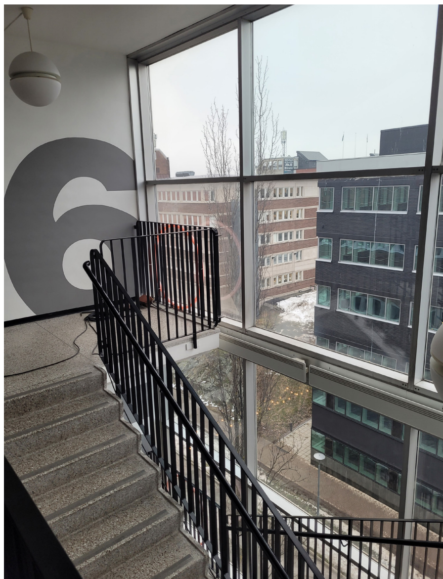
Figur 62. Trapplopp med vilplan. Utmärkande är det ursprungliga terrazzogolvet och räckena i svart smide. Härifrån har man god överblick över omgivningarna och trapploppet bidrar med ljus under de mörka timmarna och dygnet under året.
