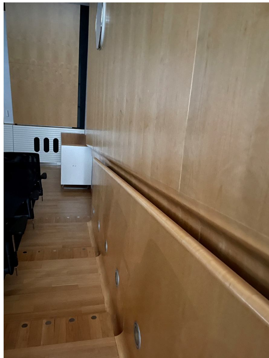
Figur 100. Integrerad handledare längs hörsalens gradängar. Träslaget är sannolikt björk.
