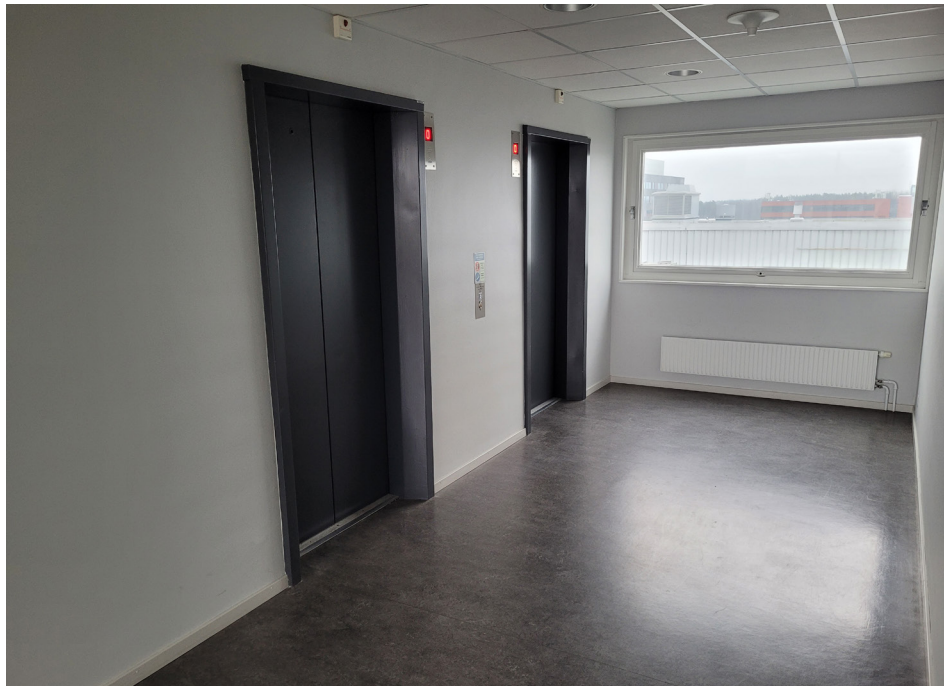
Figur 58. I anslutning till trapphusen hittas dubbla hissar. Trapphuset är öppet och får ljus från två sidor, genom trapphusets glasfasad och det liggande fönster på motstående fasad. Samtliga golv i kontorsutrymmen och trapphus är tillkomna senare. Undertak och ytskikt är inte ursprungliga.
