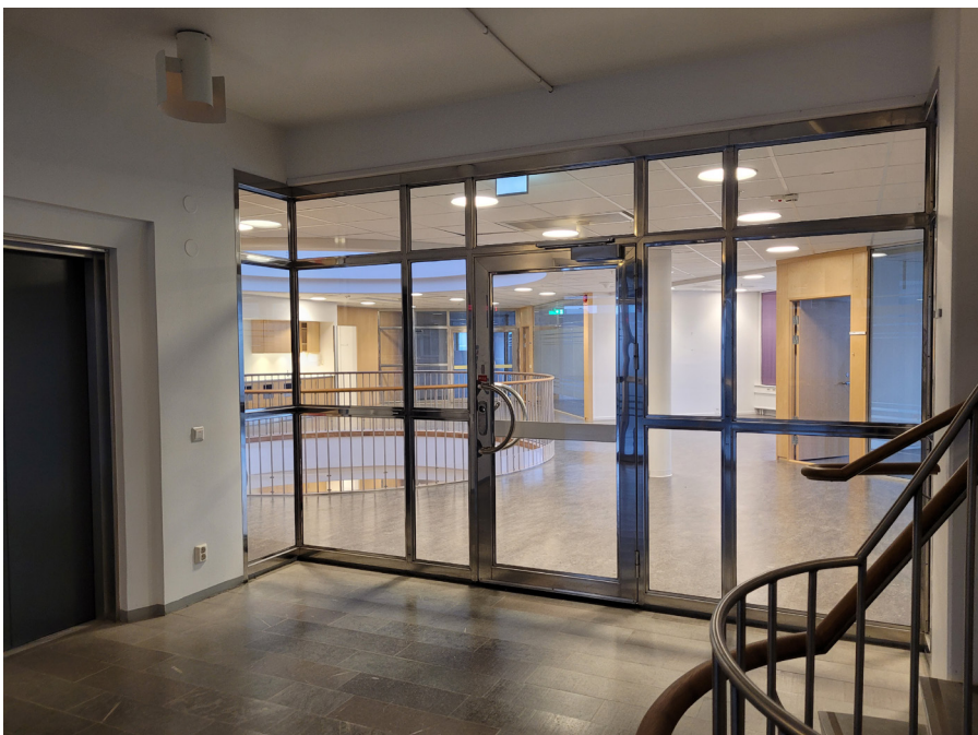
Figur 85. Trapphall med metallglasparti mellan trapphus och kontorslandskap.
