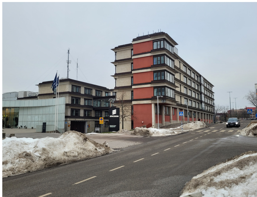
Figur 68. Kontorshuset sett från Torshamnsgatan österifrån. Här framträder det större och kraftigt utkragade burspråket i hörnet av byggnaden, volymens linjeföring och skillnaden i höjd mellan den inre och yttre volymen. Likt SRA:s anläggning hittas radiomaster på byggnadens tak. Dessa är som övriga master Ericssons egendom och kommer att flyttas.
