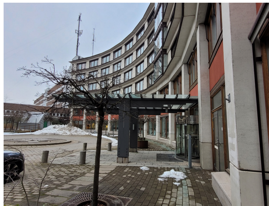
Figur 75. Byggnadens huvudentré med sina träpelare, utragande konsoler i limträ och tunna glastak. Limträkonstruktionen har tidigare varit omålad. Entrén markeras vidare med pollare av granit i marknivå. Härifrån syns telemasten på SRA:s anläggning tydligt.
