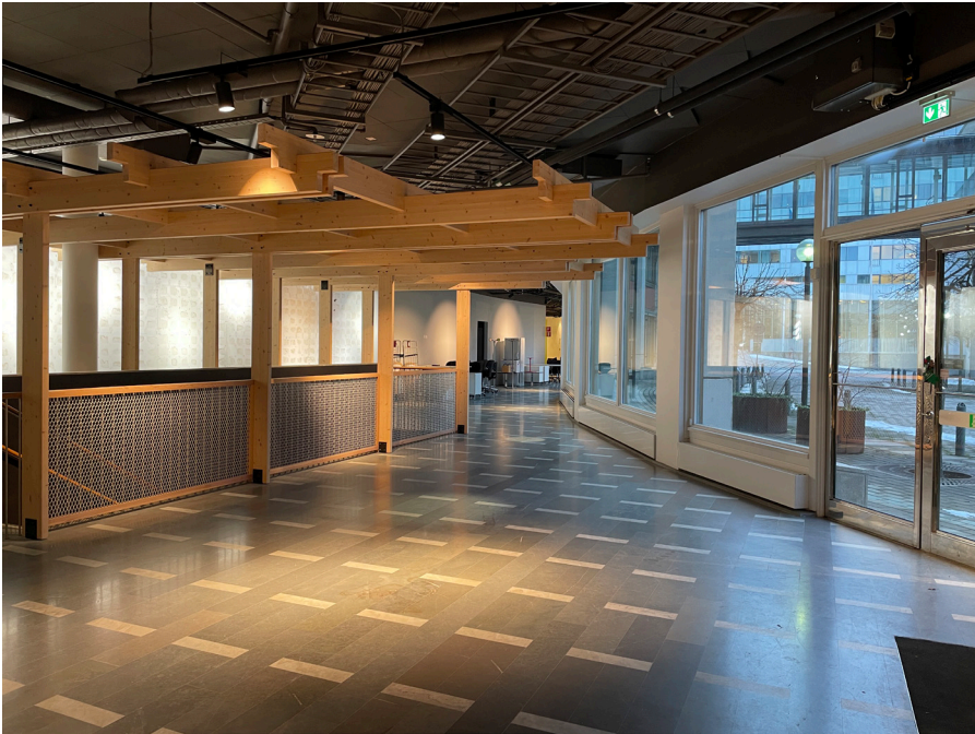
Figur 80. Entréhallen mot gården. I fonden är konferenslokalen belägen och till vänster i bild hittas trappan ned till garaget. Räcket sekundärt kompletterat med metallgaller och överbyggnad av limträ.
