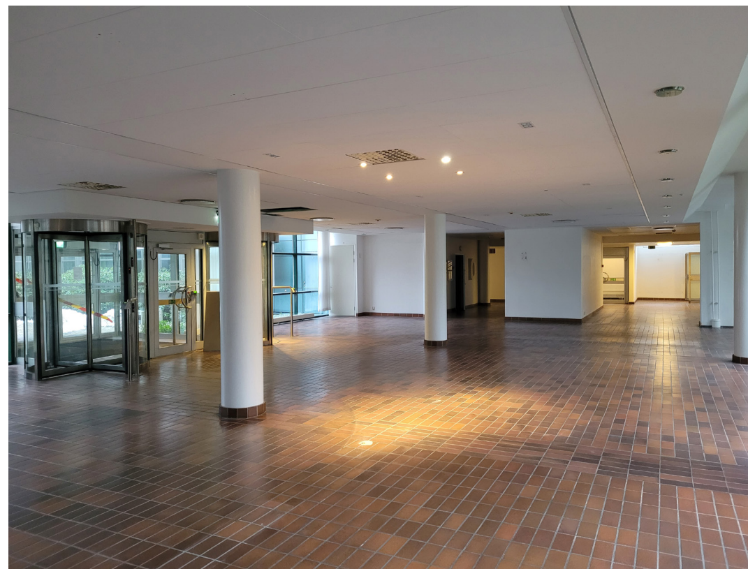
Figur 48. SRA:s tidigare entré mot gården vid Grönlandsgatan. Entrén skymtar till vänster i bild och består av ett vindfång och karuselldörrar av metallglaspartier. Byggnadens bärande konstruktion framkommer av de runda pelarna längs ytterväggar och i byggnadens mitt. Utrymmet präglas av den sammanhängande golvytan av klinker. Golven uppvisar varierande schatteringar från ljusa bruna kulörer till rödbruna och mörka. I höjd med de bärande pelare är klinkern lagda på tvärs i förhållande till övriga golvet. Formatet på klinkern varierar något i de utrymmen det förekommer.
