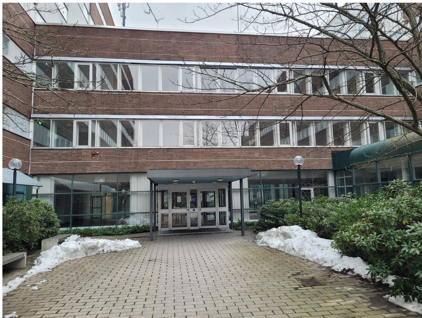
Figur 29. Den tidigare huvudentrén till SRA:s anläggning i den tvärställda lägre volymen mellan hus 1 och 2. Gårdarna följer de yttre fasadernas gestaltning med tegel och fönsterband. Bottenvåningen är helt glasad med bärverk av metall och bidrar till en genomsiktighet som sträcker sig in på nästa gård.
