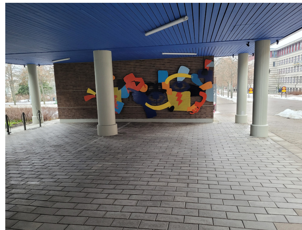
Figur 46. Passagen under hus 1A mellan Kistagången och entrégården präglas av sitt sekundärt monterade konstverk och det blåmålade undertaket med den asymmetriskt placerade belysningen. Notera de sekundärt tillkomna kragarna på de för modernismen så karaktäristiska pelarna.
