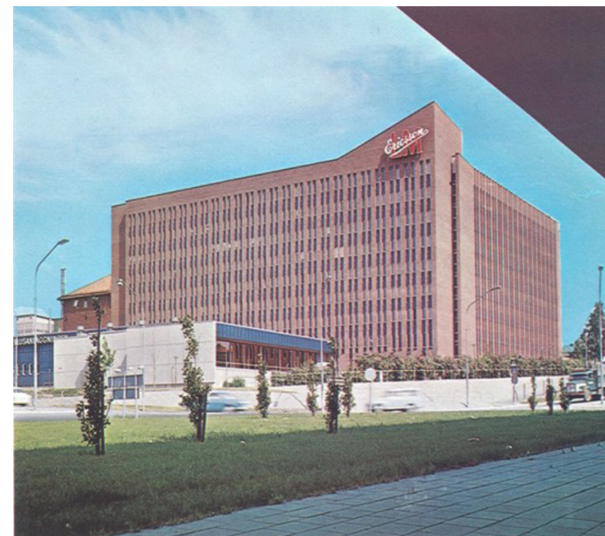
Figur 5. Ericssons komplex för utbildning och datacentral längs med E4:an, efter ritningar av Anders Berg Arkitektkontor, 1970. Källa: Ericssons årsredovisning 1970.
