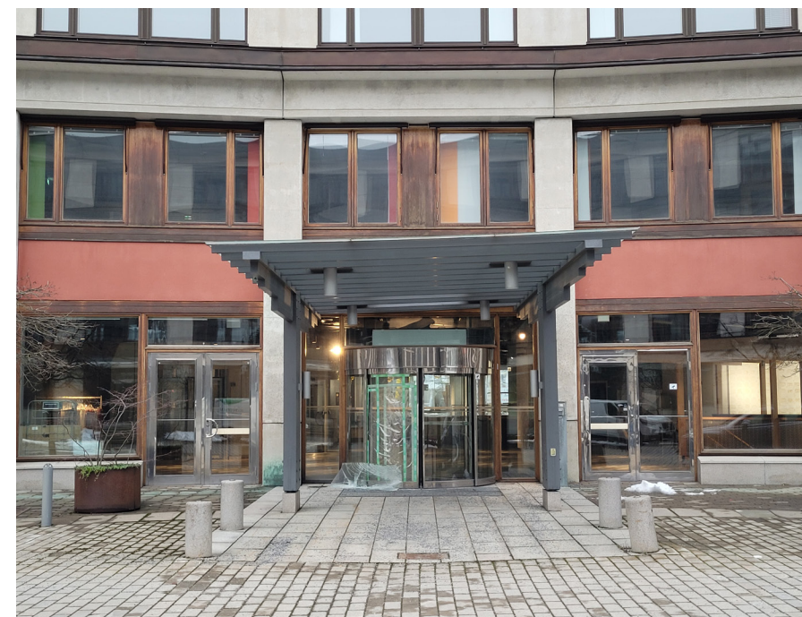
Figur 77. Huvudentrén från gården. Entrén utmärks av sin nätta karaktär och öppenhet mot det inre av byggnaden. Även här hittas en karusell dörr samt två flankerande dörrar i glasmetsall. Även markbehandling och pollare markerar entrén.
