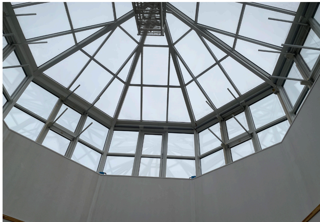
Figur 92. Taklanterninen sedd från plan 6. Lanterninen har en historiserande form med en oktagonal trumma och tälttak av ribbverk och glas.
