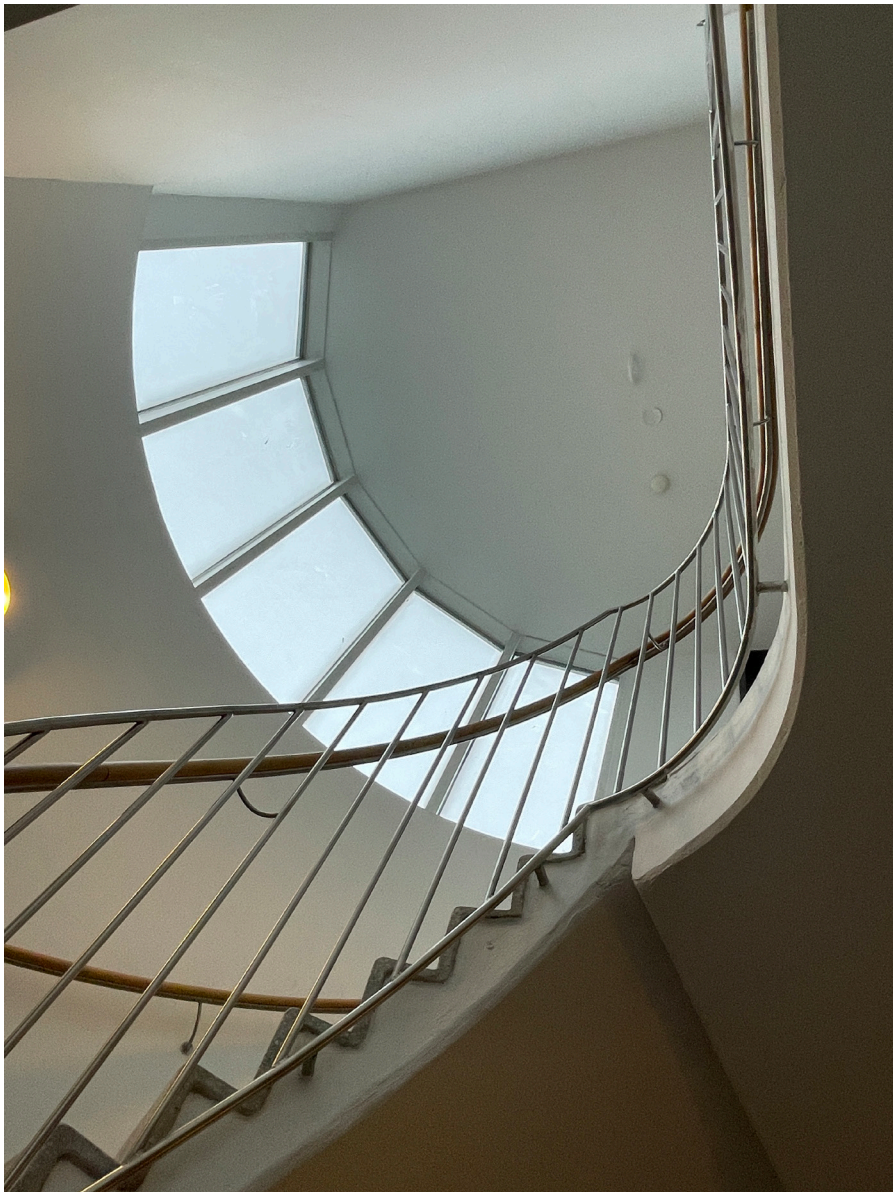
Figur 96. Fönster i takuppgbyggnad som släpper ned ljus till trapphuset.
