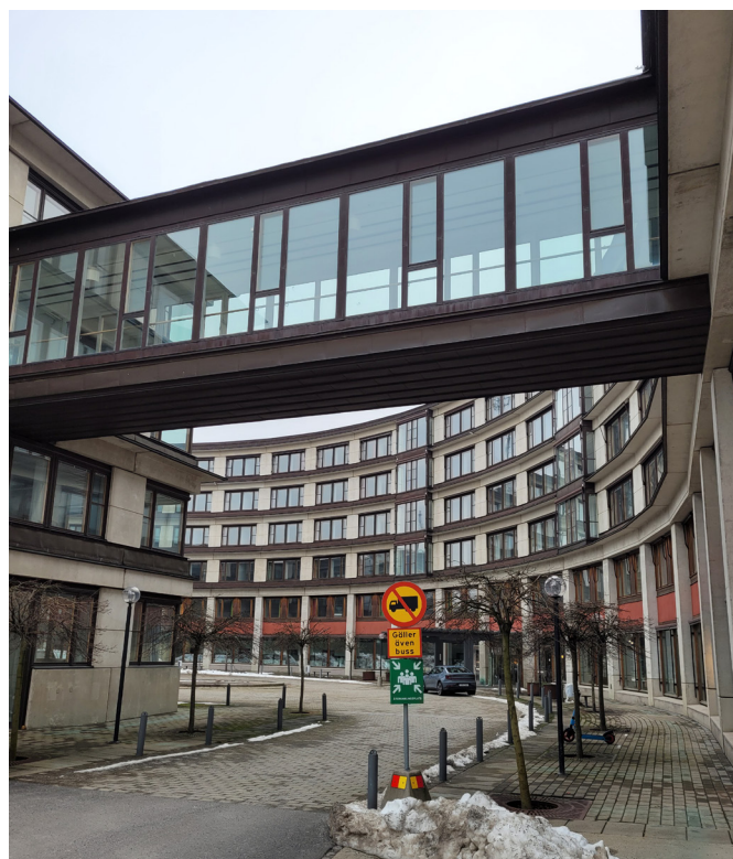
Figur 74. Öppningen mot gården till Torshamnsgatan 23 och byggnadens huvudentré. Från gårdsbyggnadens gavel till gatubyggnaden hittas en förbindelsegång med glasfasader.
