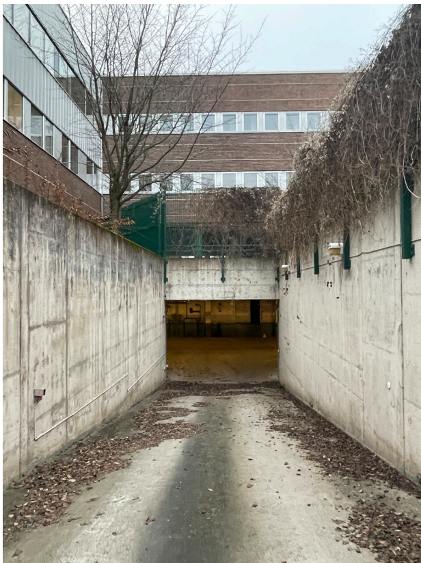
Figur 36. Rampen mot garaget på gården mellan verkstadsdelen och hus 2B. De släta betongväggarna utgör en stram kontrast mot det uppvuxna vildvinet på murarnas krön.
