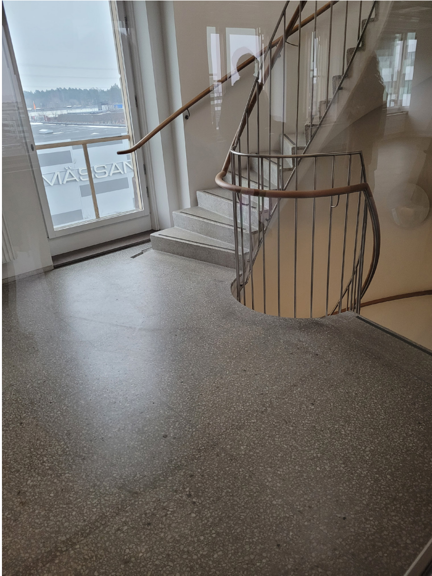
Figur 93. Trapphus med dagsljusinsläpp från Torshamnsgatan, terrazzogolv, smäckra stål-räcken med trähandledare utgör kvalitativa arkitektoniska inslag i kontorsmiljön.
