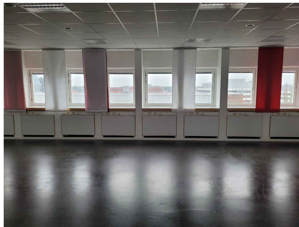
Figur 53. Kontorslandskap (hus 1A) i rumsligheter som tidigare varit försedda med cellkontor. Fönstersättningen är tät. Utrymmena är försedda med sekundära enkla plocktak, elementskydd under fönstren samt dosor för el, tele och fiber.
