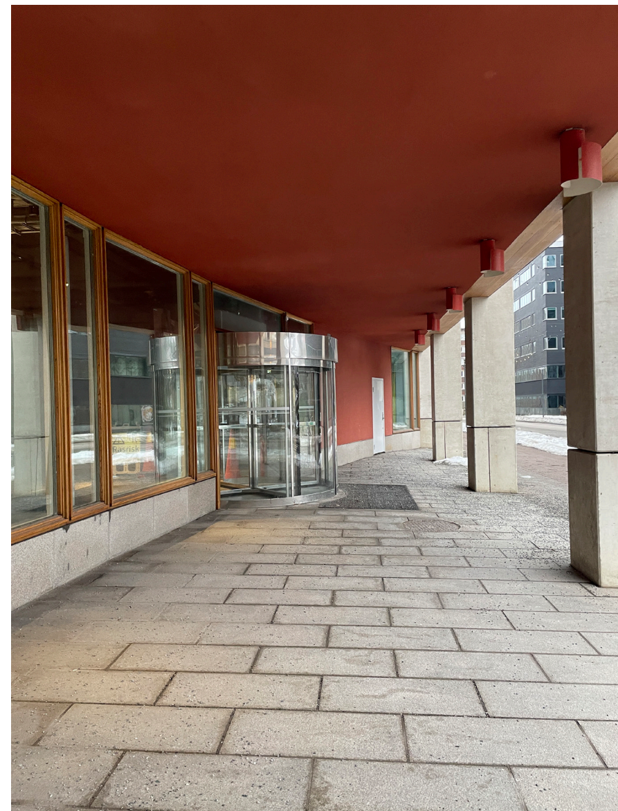
Figur 72. Besöksentrén från Kistagången. Fasaden är indragen och svängd. Kurvaturen motsvarar gårdens krökning. Den röda kulören återkommer på de putsade ytorna på fasaden.. Fönsterbågarna är av ek. Armatur av Nyréns, här i samma kulör som det putsade undertaket, återkommer i interiören. Karusell dörr av glasmetall.
