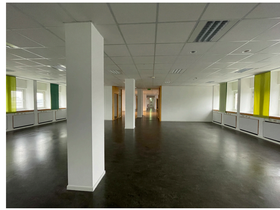
Figur 55. Öppet kontorslandskap (hus 1A och 1B) som ovan. Den bärande rektangulära pelaren markerar läget för den tidigare mittkorridoren som förlades längs stolpens ena långsida så att en djupare och en grundare sektion bildades.
