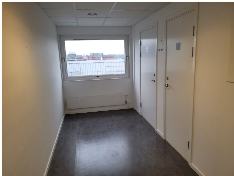
Figur 59. I anslutning till trapphusen är kapprum med wc-utrymmen lokaliserade. Pivåhängda perspektivfönster är inslag som inte är typiska för 1970-talet utan som användes mer kring 1900-talets mitt.
