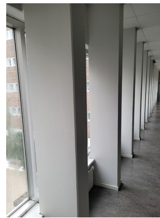
Figur 56. Korridoren på vän ett ovanför gamla entrén. Här avviker fönstersättningen i förhållande till övriga fasader genom lägre bröstningshöjd. Notera hur fasaden är fristående från pelarna.
