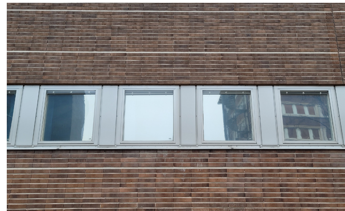
Figur 24. Fönsterband med skiljande plåtar i aluminium. Innanför dessa plåtar kunde tvärväggar anslutas.
