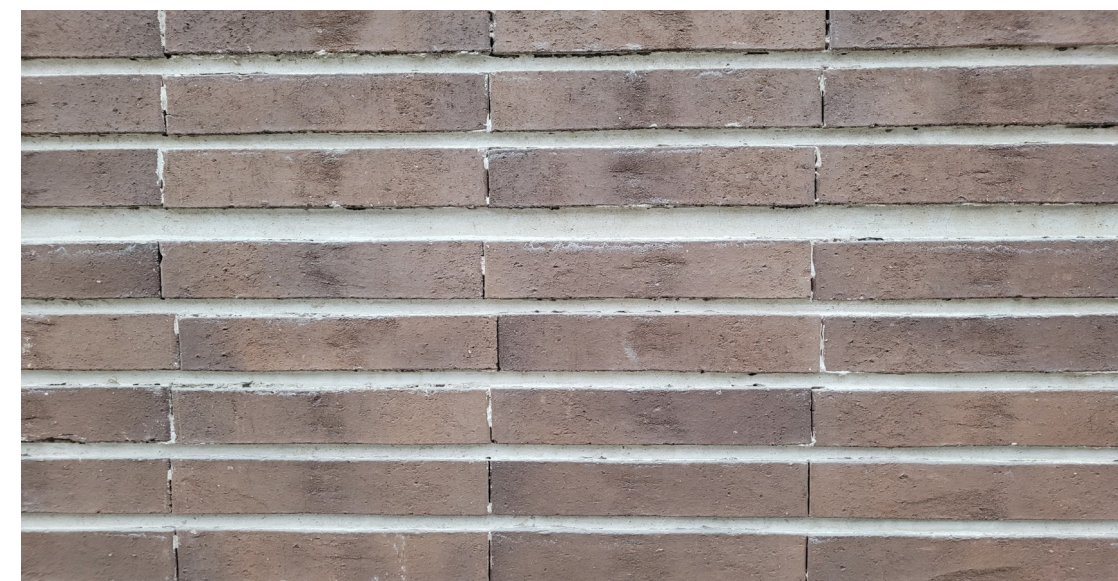
Figur 25. Breda, tryckta fogar bidrar tillsammans med fönsterbanden till fasadernas rand- och linjeverkan.
