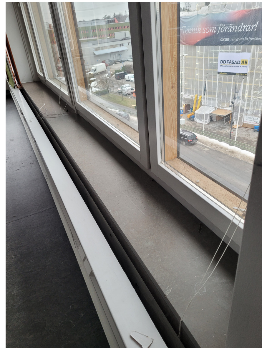
Figur 101. I byggnaden finns fönsterbänkar av kalksten och fönsterbågar av furu. Flertalet är i senare skede målade vita, ursprungligen var de lackade.
