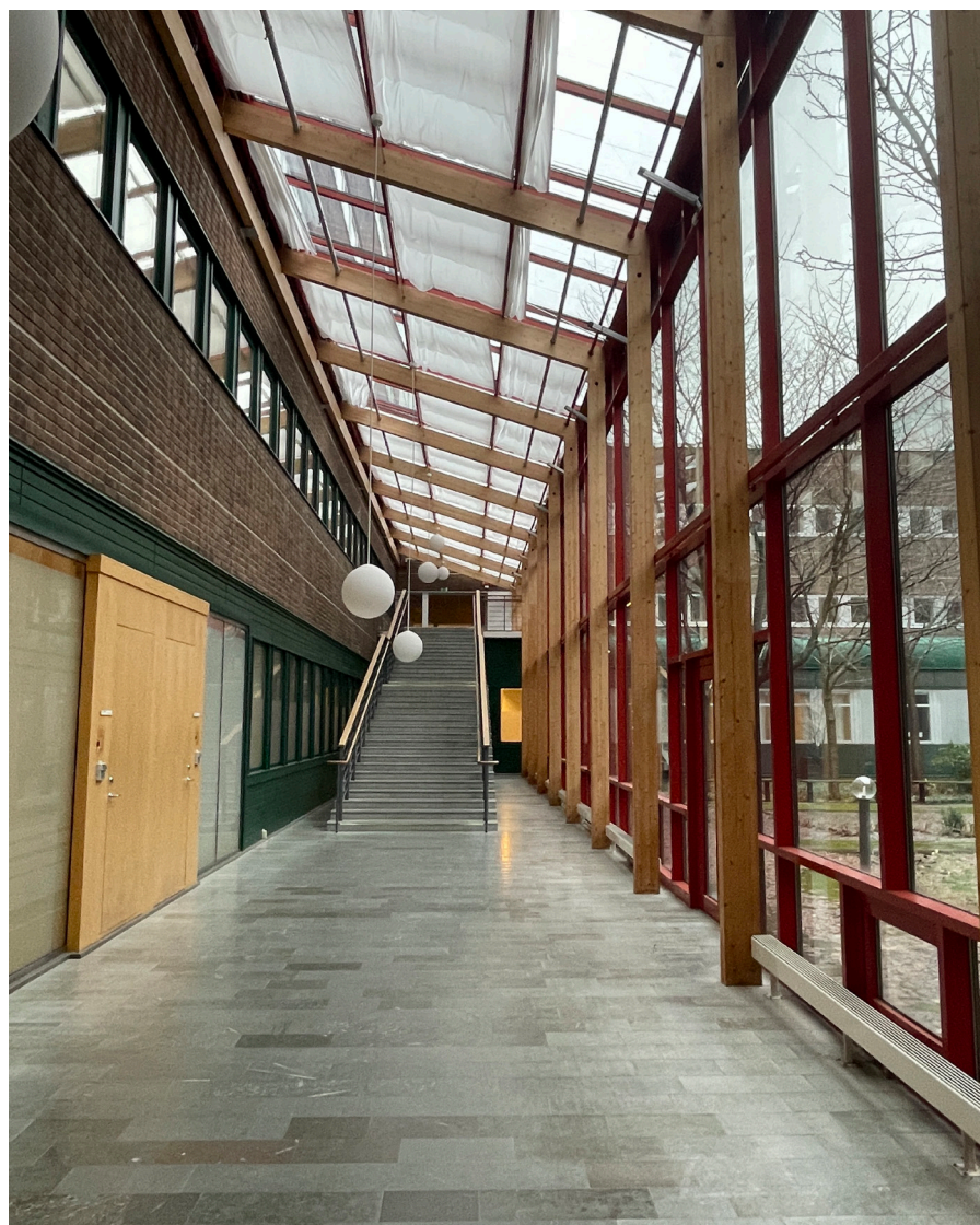
Figur 50. Den tillbyggda gången på gården mellan hus 1A och 2A som föbinder SRA:s gamla huvudentré med ERA:s nya huvudentré. Notera hur limträkonstruktionen är skild från klimatskalet.
