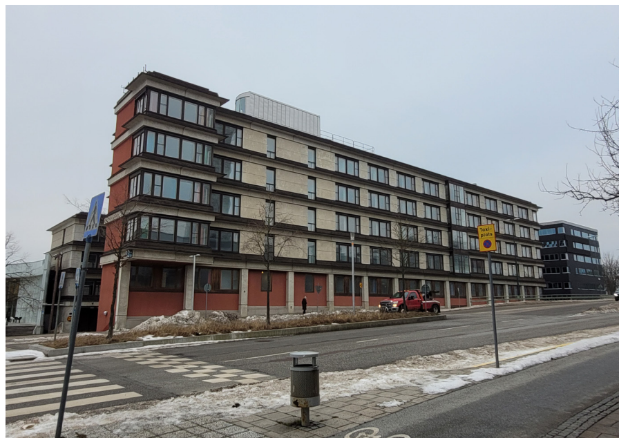
Figur 69. Gatufasaden längs Torshamnsgatan med sin variation av rödputsade ytor, ljus fasadsten och utkragade våningsband. På taket märks trapphusets överbyggnad som ger tillträde till taket. Det slutna partiet markerar trapphus, hiss och kapprum. Sockelvåningen med sin pelarrad fungerar utjämnande i förhållande till gatans nivåskillnader.
