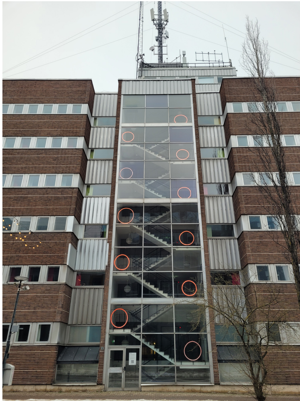
Figur 26. De vertikalt betongade glasade trapphusen karaktäriseras av de synliga trappploppen med sina vilplan vilket bidrar till en tydlig regelbundenhet och rytm. Trapphusens vertikala prägel markeras genom de indragna partierna i plåt på ömse sidor. Den korrugerade plåten återkommer på fasadpartierna på de översta våningarna och bildar en kontrastverkan mellan matt och blankt, i och viss mån även slutet – öppet samt horisontellt – vertikalt. De röda lysande cirkarna i trapphuset är ett sekundärt tillkommet och temporärt konstverk. Trots byggnadens höjd är de påbyggda telemasterna väl synliga från gatan, utgör landmärken och markerar Ericssons närvaro i stadsdelen. Dessa är emellertid Ericssons egendom, fortfarande i bruk och kommer framöver att fungera som landmärke men från annan plats i Kista.
