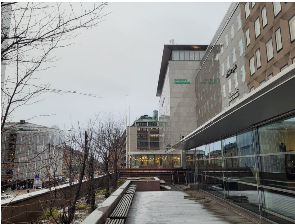
Figur 34. Terrasstillbyggnaden har närmast helt uppglasad långsidesfasad med minimal sockel och markerad men sparsmakad takfot. Tillbyggnaden, planteringslådor, bänkar och växtlighet kommer inte att kunna vara kvar i nuvarande form om planförslaget realiserar.
