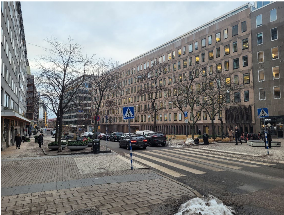
Figur 45. Befintlig situation fasad mot Malmskillnadsgatan norrifrån.
