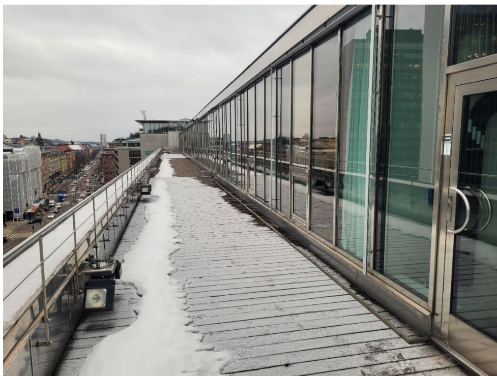
Figur 36. Takvåningens fasad och terrass mot Sveavägen. Fasaden är konsekvent utförd i rostfria stålprofiler och glas.
