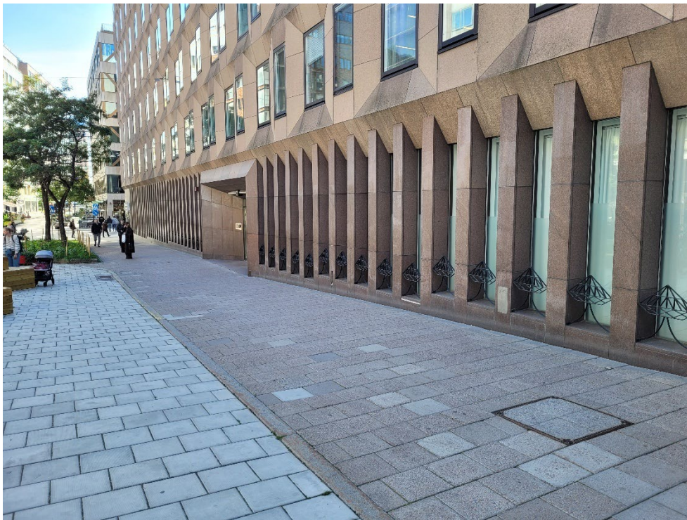
Figur 31. Den rustika sockelvåningen med smidesdianter mot Malmskillnadsgatan, ett uttryck för bankarkitekturen och vittnesbörd och byggherren Göteborgs bank. Förslaget innebär att bankens imposanta huvudentré med stenomfattning blir kvar men själva entrédörrarna byts. Ändringar sker i sockelvåningen som föreslås öppnas upp genom att ta bort varannan pelare. Smidesdianterna utgår i samband med åtgärden.
