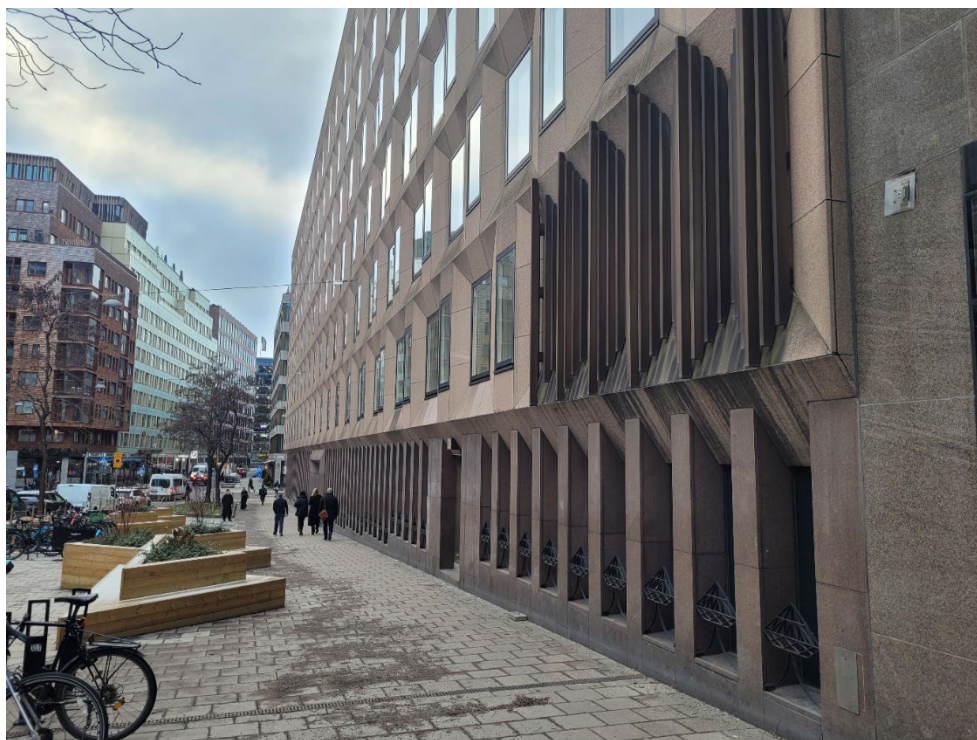
Figur 43. I den norra delen av fasaden är sockelns stenpelare lägre genom markens lutning. De är här samkomponerade med det konstfullt bearbetade ventilationsgallret på vån 1 tr. I denna del avses pelarna bevaras.
