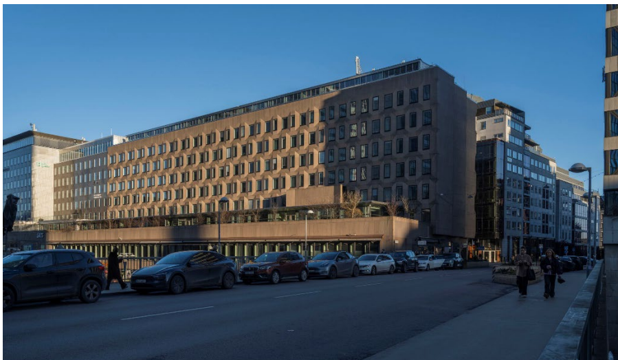
Figur 4. Befintlig bebyggelse inom Putten 15, gatuvy från Mäster Samuelsgatan. Foto: Gustav Kaiser. Beskuret foto.
