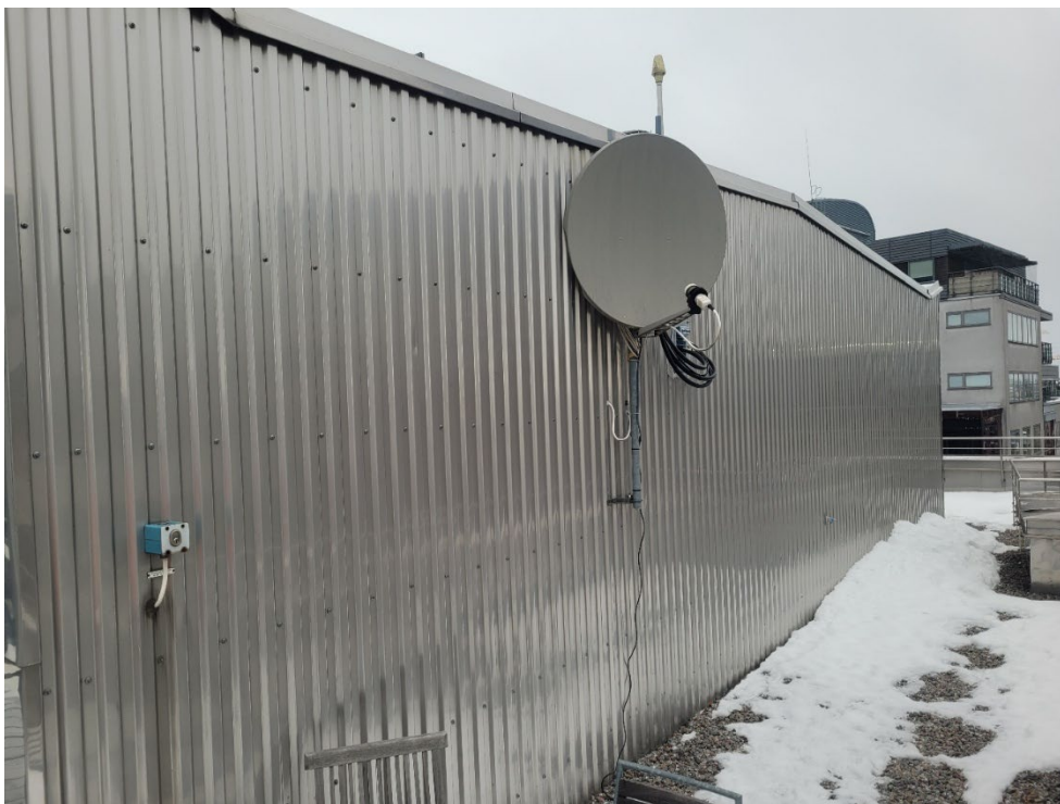
Figur 37. Takvåningens södra gavel är klädd i rostfri profilerad plåt. Endast delar av taket är avsett som terrass, stora ytor är belagda med singel.
