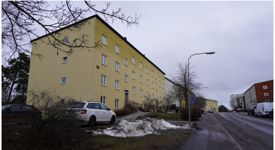
Bebyggelse inom Låsfjädern 1 intill planområdet. Foto: Stadsbyggnadskontoret.
