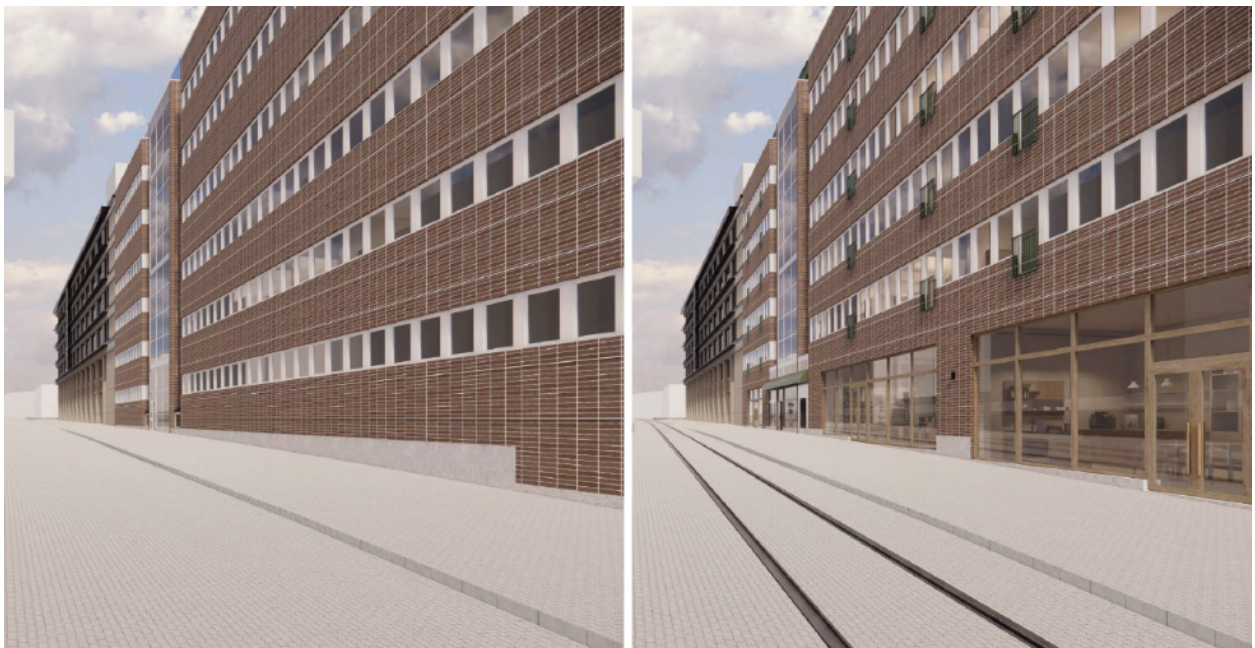
Före- och efterbild som visar fasadändringar mot Kistagången. Bottenvåningen har öppnats upp för att möjliggöra nya lokallägen. (Bild: Strategisk Arkitektur).
