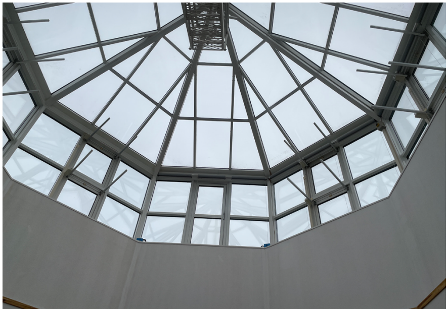
Taklanterninen sedd från plan 6. Lanterninen har en historiserande form med en oktagonal trumma och tälttak av ribbverk och glas. (Bild Tyréns).
