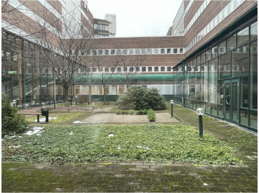
Exempel på en av innergårdarna i 70-talsbyggnaden. (Bild: Tyréns).
