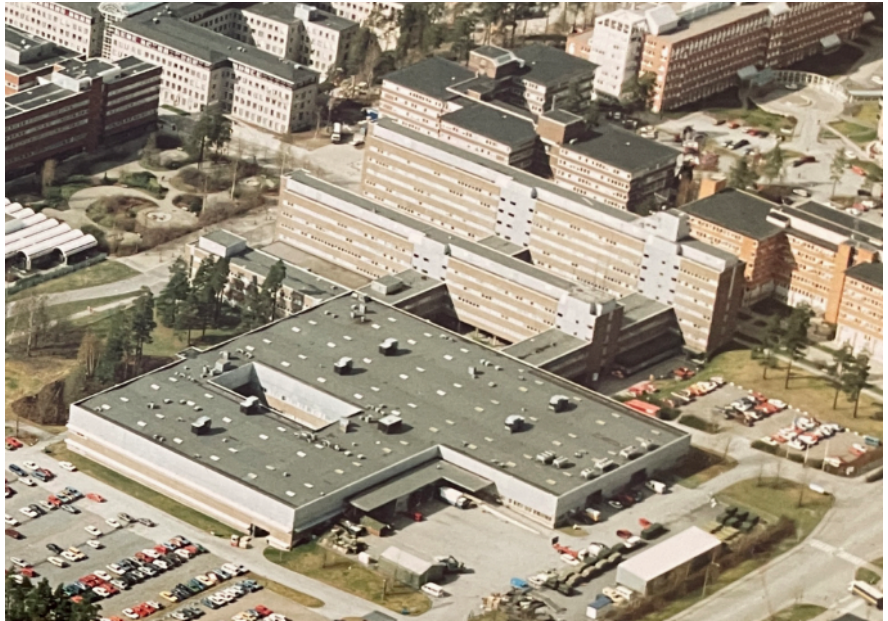
Flygbild över SRA:s anläggning kring år 1990. (ARKDES, från kulturmiljöutredning)
