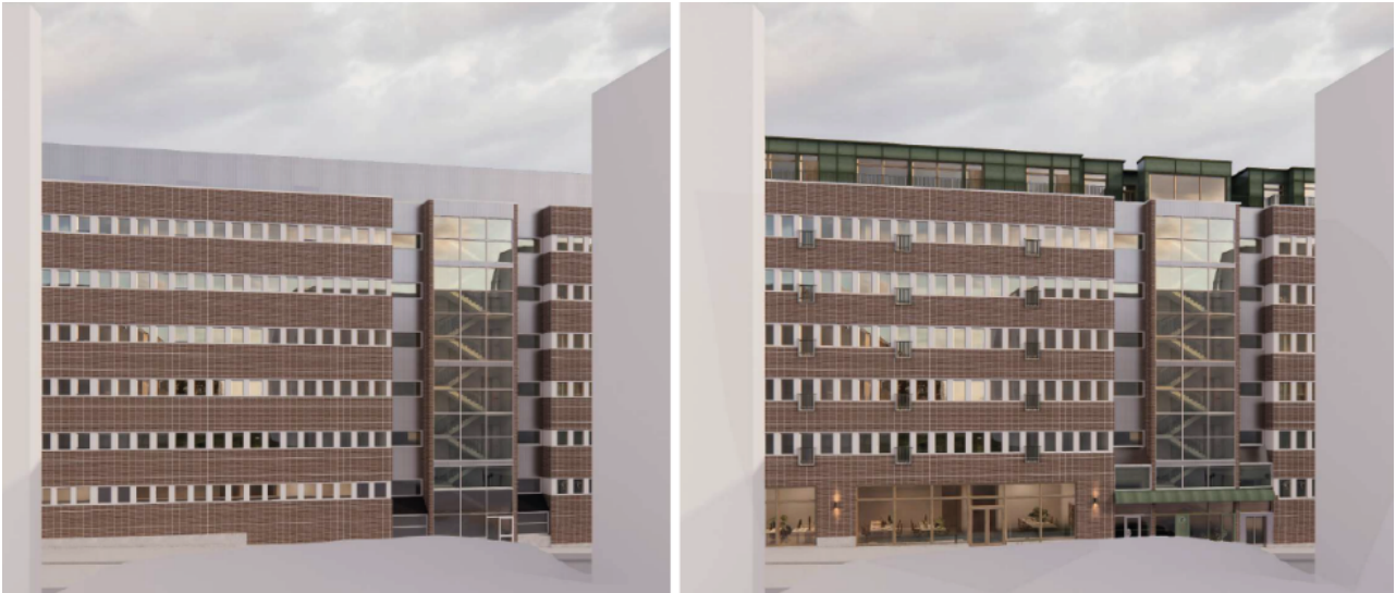
Före- och efterbild som visar fasadändringar mot Kistagången. Teknikvåningen har ersatts med en ny takvåning i grön plåt och trädetaljer. Entrépartierna mot Kistagången har kompletterats med nya entréer för hiss samt ett skärmtak som hjälper till att annonsera entréerna och skapa ett omsorgsfullt uttryck. (Bild: Strategisk Arkitektur).
