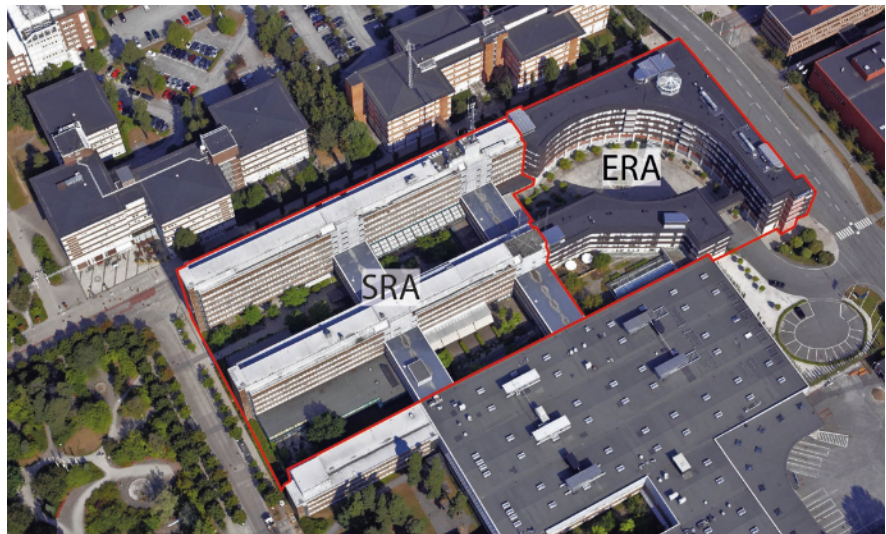
Flygbild som visar relationen mellan de två byggnadskomplexen, SRA från 1976 och ERA från 1994.
