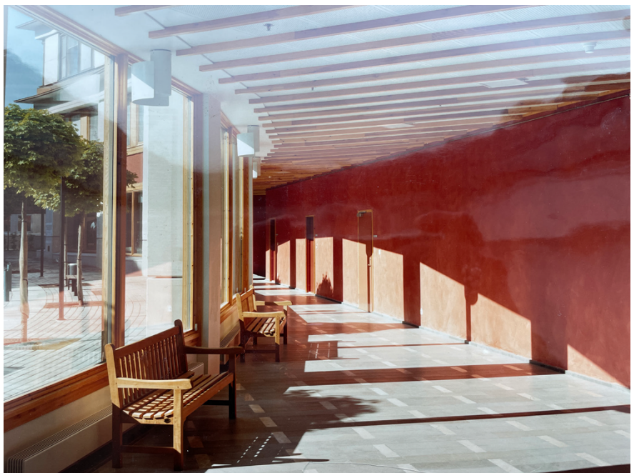
Förbindelsegång i gathuset i ERA-huset mot SRA:s byggnad. Väggen är målad med en röd äggoljetempera enligt ritning. Undertaket med de diagonalställda träribborna som kontrasterar mot det vita undertaket. (Foto: Max Plunger. Källa: Nyréns arkitektkontor, från kulturmiljöutredning).
