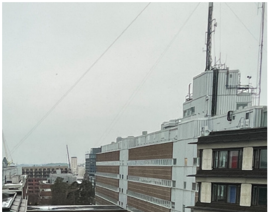
Taklandskap på 70-talsbyggnaden med teknikvåning i plåt som binder ihop teknikvåningen med trapphusens plåtfasader. (Bild: Tyréns)
