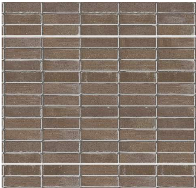
HÅRDBRÄNT BRUNT TEGEL STAPELFÖRBAND MED BREDA FOGAR FASAD
