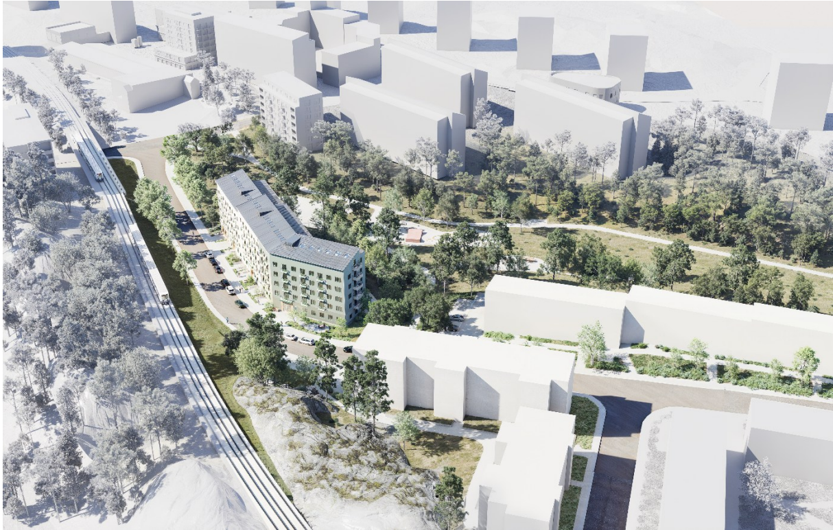
Vy av planförslaget sett från sydväst.
