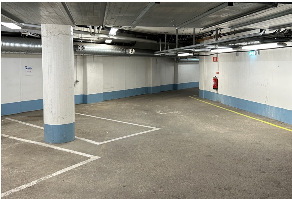
Figur 7: En del av befintligt parkeringsgarage.
