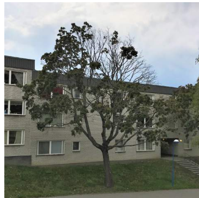
Döda grenar bör tas bort för att förhindra att grenar faller ned. Lönnallé utmed södra Rinkebygången.
