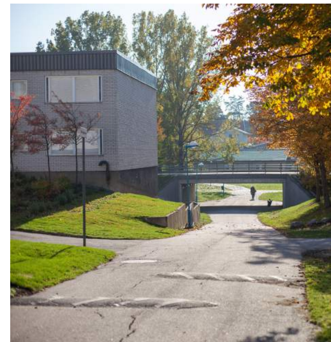
Farthinder i form av så kallade asfaltslimpor, intill Sörbygången i Rinkeby.
