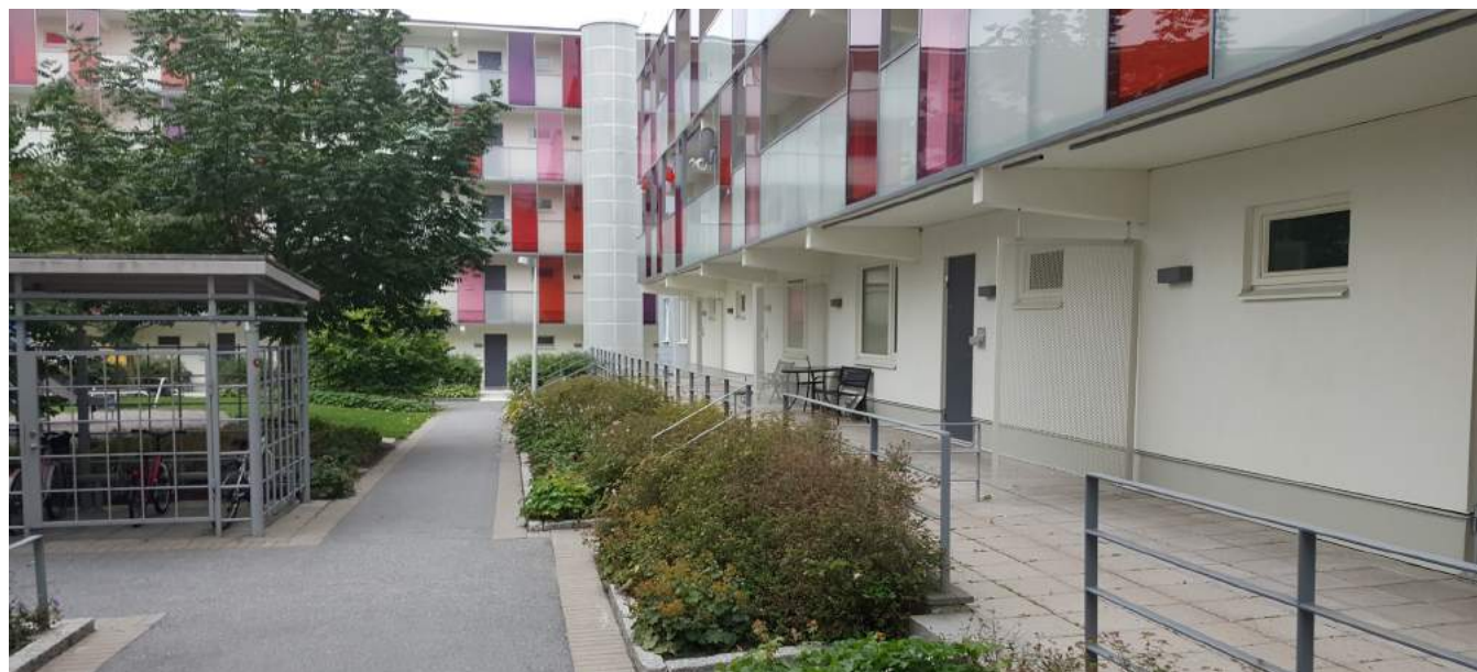
Renovering av kvarteret Molde 1 i Husby utfördes 2009 som ett tidigt projekt inom Järvalyftet.
