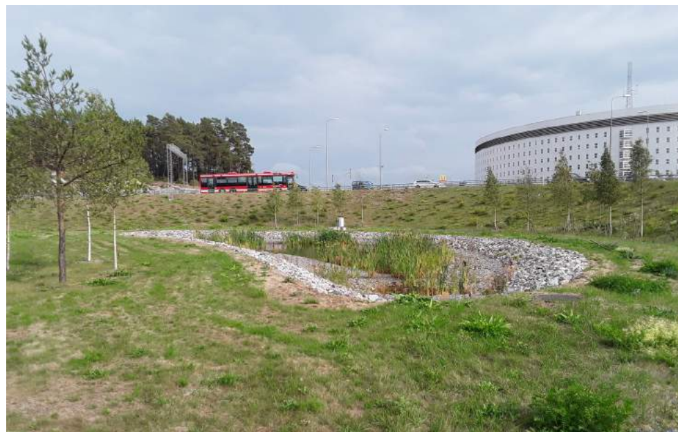
Dagvattenanläggning öster om Rinkebysvängen.
