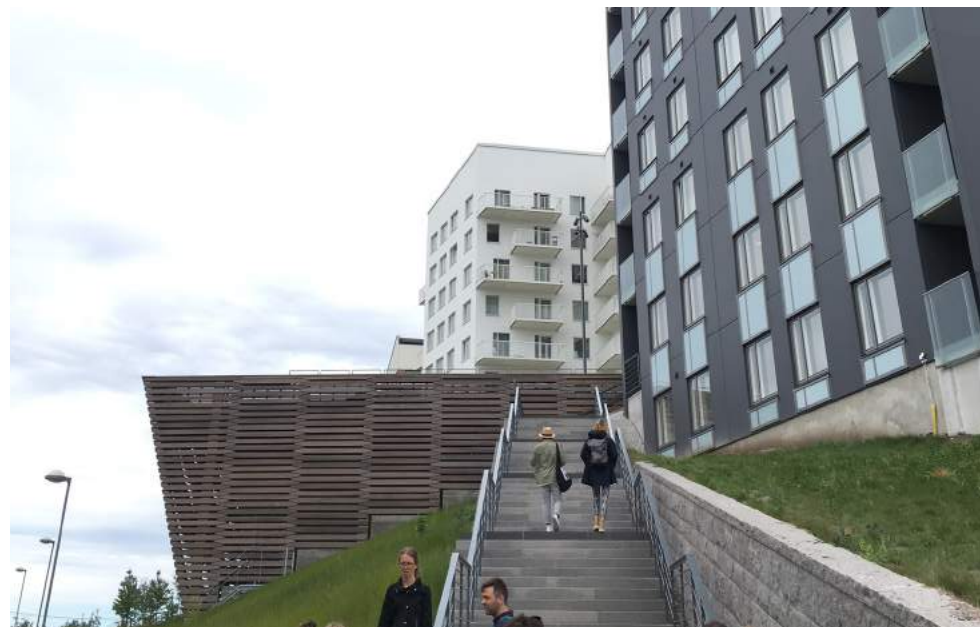
Trappa mellan utsiktsplats och Järvafältet.
