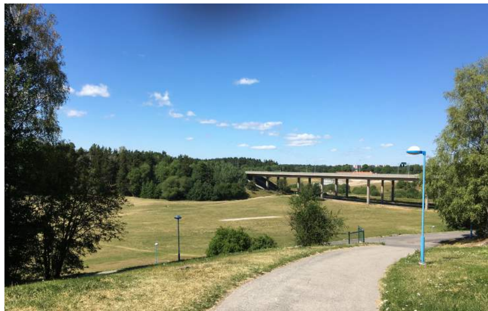
Utsikt över Norra Spångadalen och koppling under Hjulstavägen.
