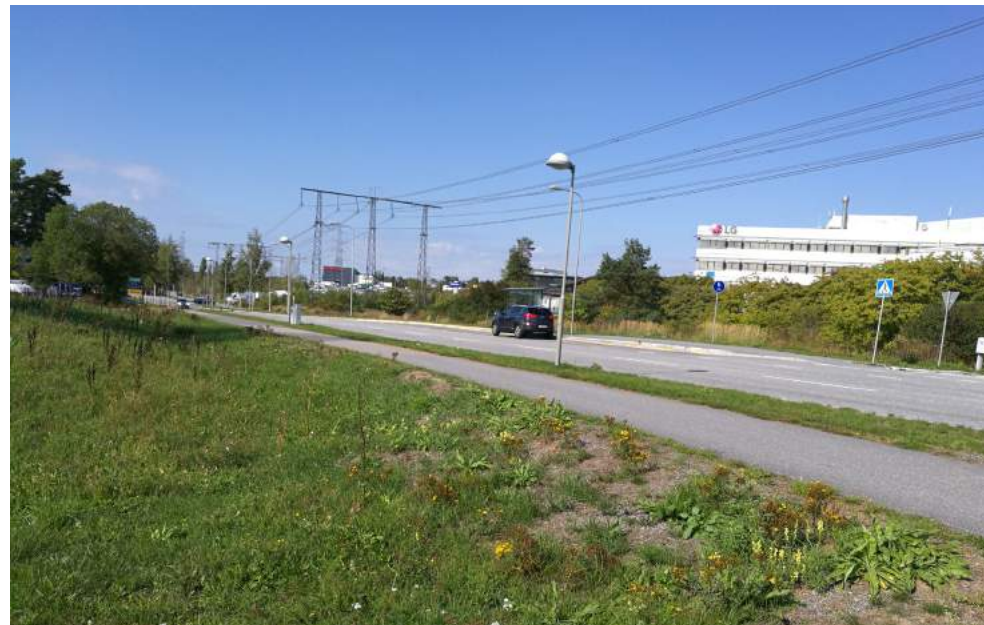
Kraftledningsgata sett söderifrån.
