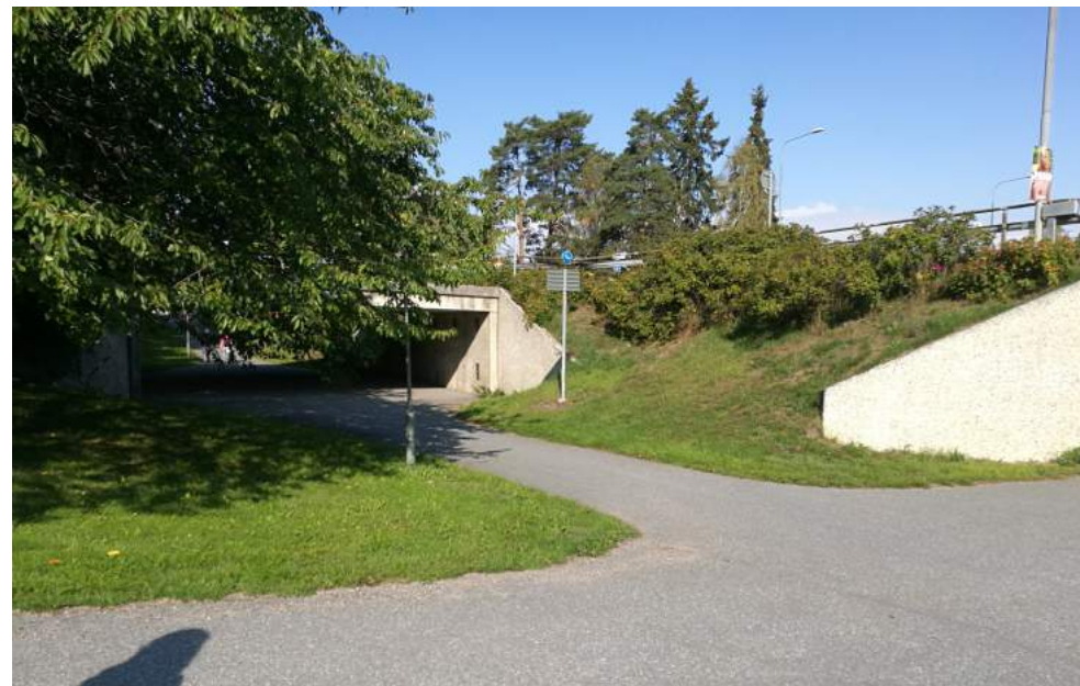
Gångtunnel som stråket leds genom.
