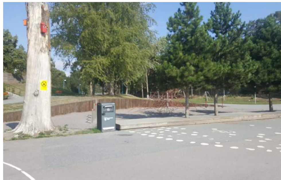
Målas asfalt, klätternät och trädäck i lekparken.
