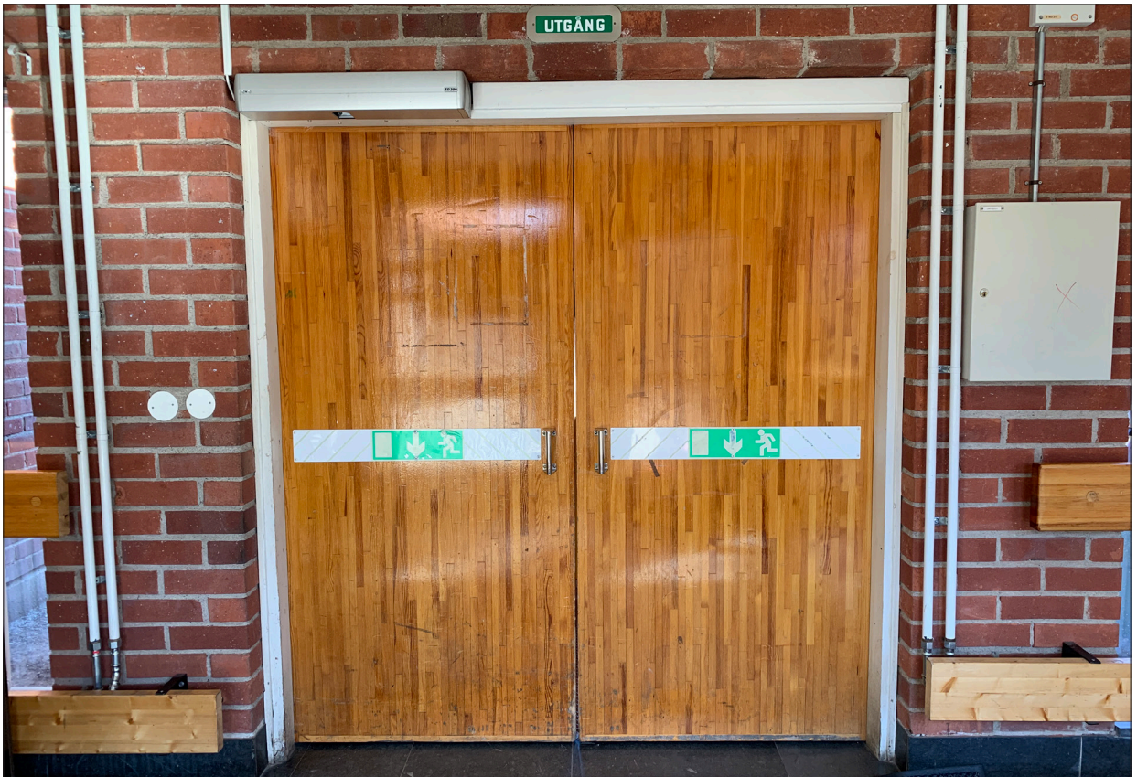
Invändiga dörrar i original är klädda med stavlimmad och lackad furu. På bilden ovan huvudentréns inre dörrpar, det yttre är bytt mot ett sentida aluminiumparti.
