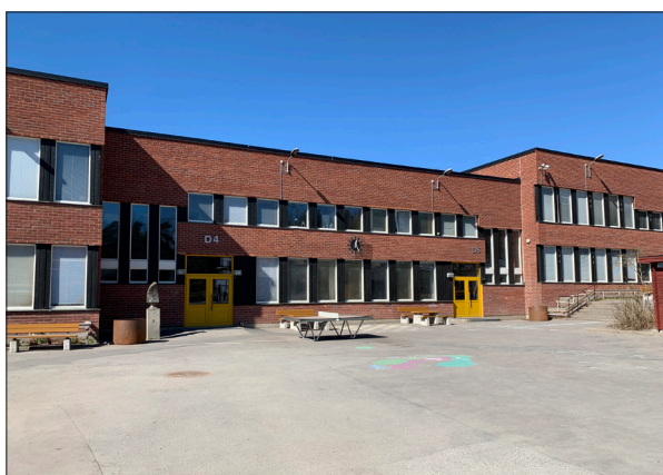
Hus D från öster, mot skolgården. Originalportarna som syns på s. 12 har ersatts av nya i aluminium.
