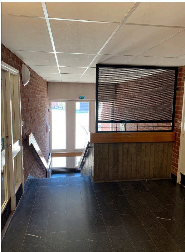
Trapphusen är i hög grad väl bevarade. Gallret ovan trappräcket är en yngre komplettering för att motverka fallrisk.
