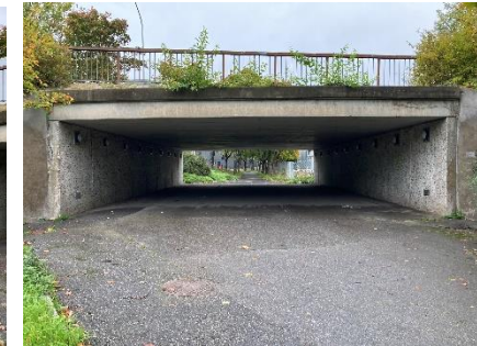
Gångtunnel under Björksättravägen
