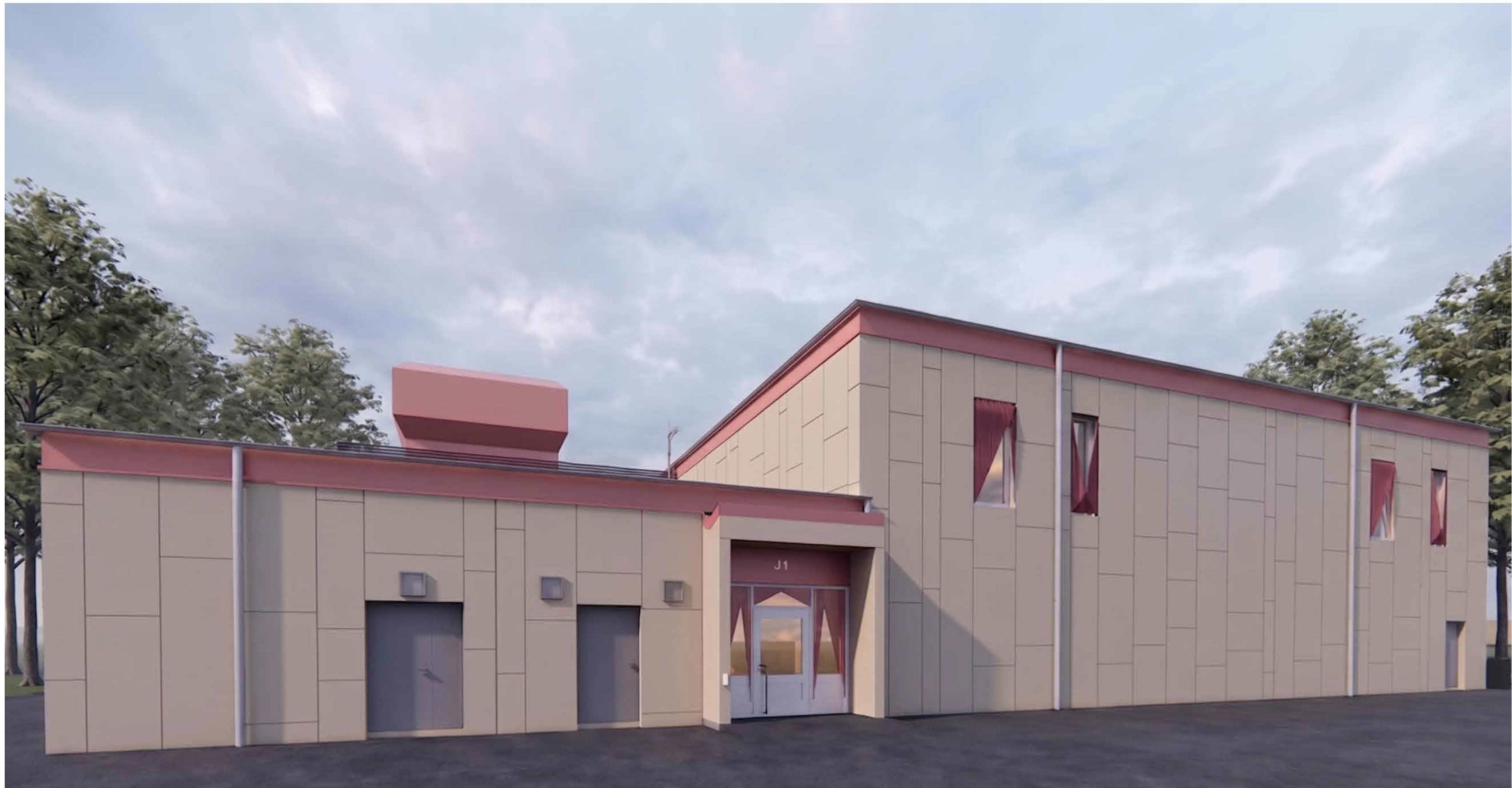
Entréfasad hus J
