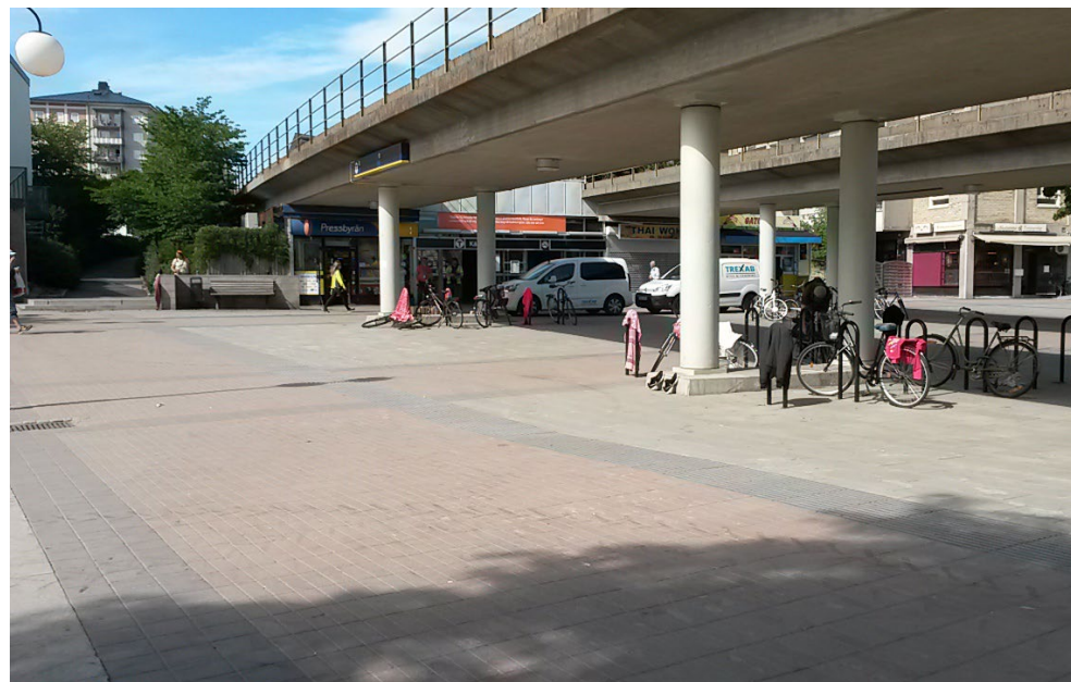
Cykelparkering under tunnelbanespåren.
