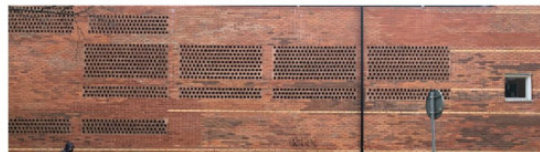
Exempel på parkeringshus i Skarpnäck med mönstrad fasad i ljusrött tegel.
