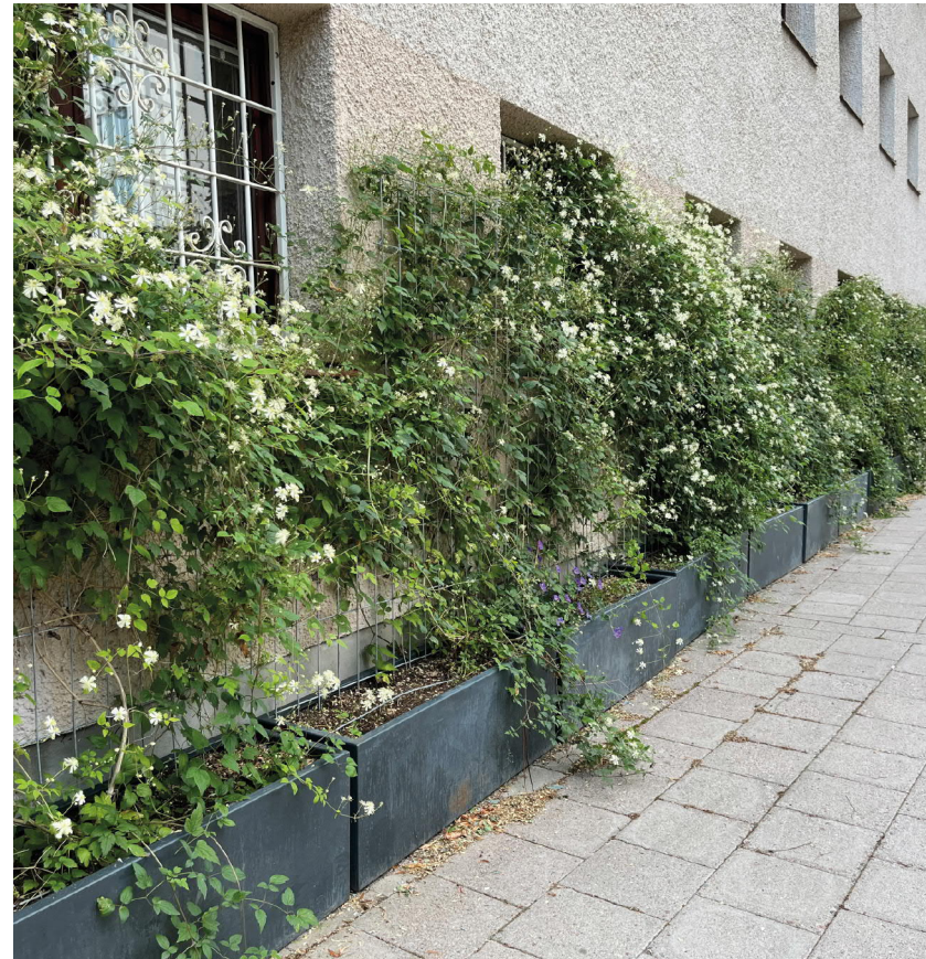
Vid långsidan av husets baksida kompletteras befintliga klätterväxter med antingen vajernät eller med svetsat, försinkade gallerspäljer (lika som befintliga men fästa i väggen) ovanför för att låta de befintliga klätterväxterna klä in en större del av väggen samt få bättre stöd.
