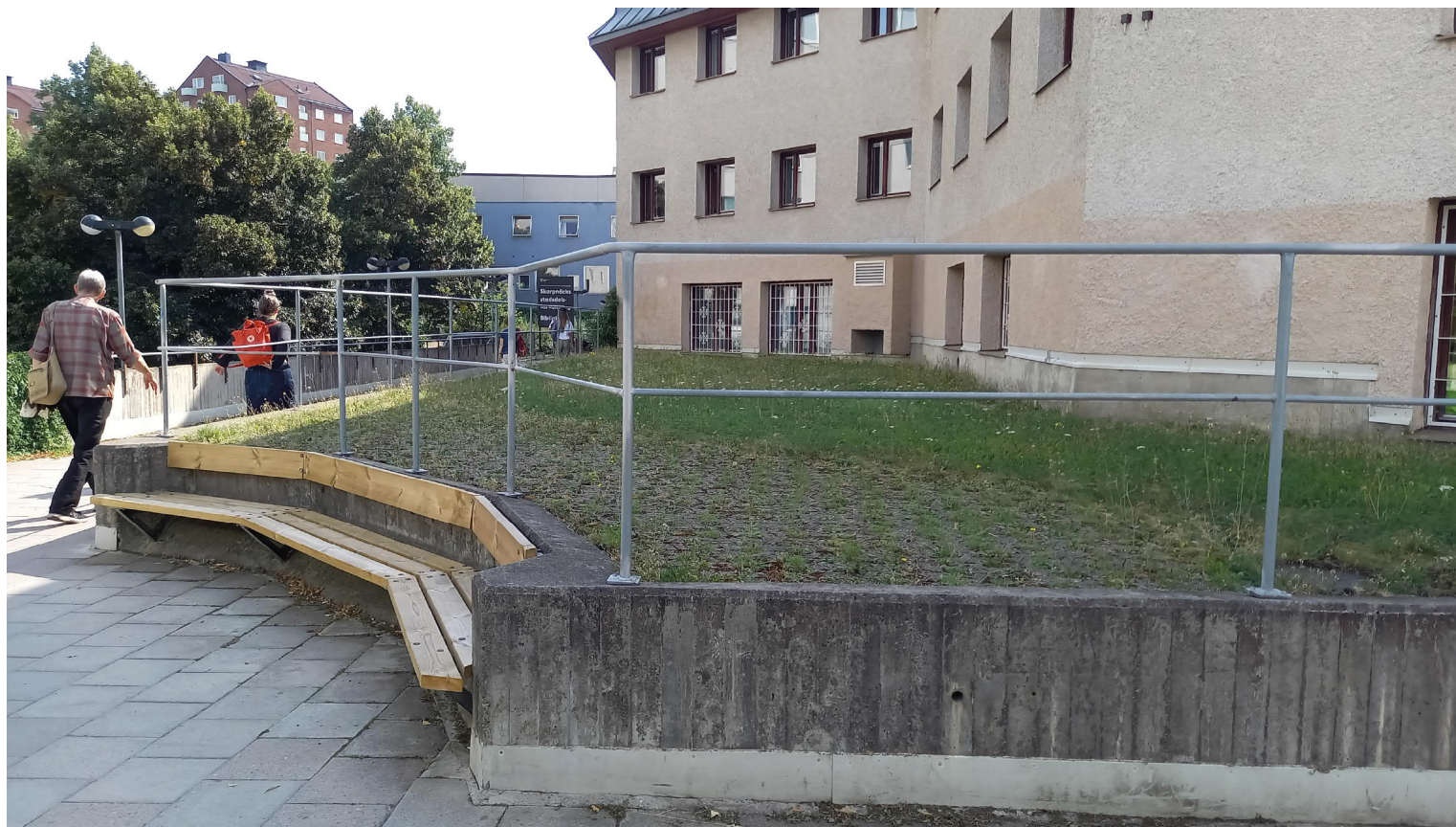
Den låga ytan vid husets noröstra hörn kan antingen grävas upp och förses med en biotopmatta från ex. Veg Tech. Som billigare alternativ kan befintliga växter tillåtas att växa högre än de får idag, och kompletteras med faunadepåer i form av död ved.
