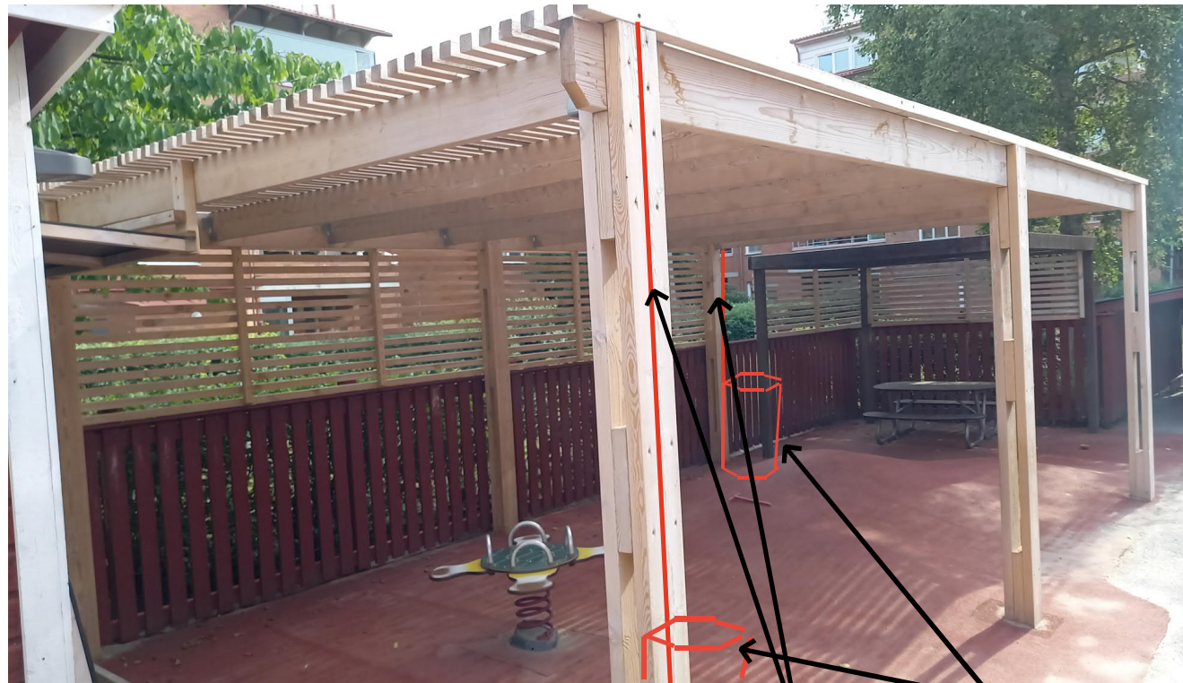
Komplettering med planteringskärl med klättrväxter, bevattning och gröna vajern. Gröna Vajern Krukor med bevattningstank
