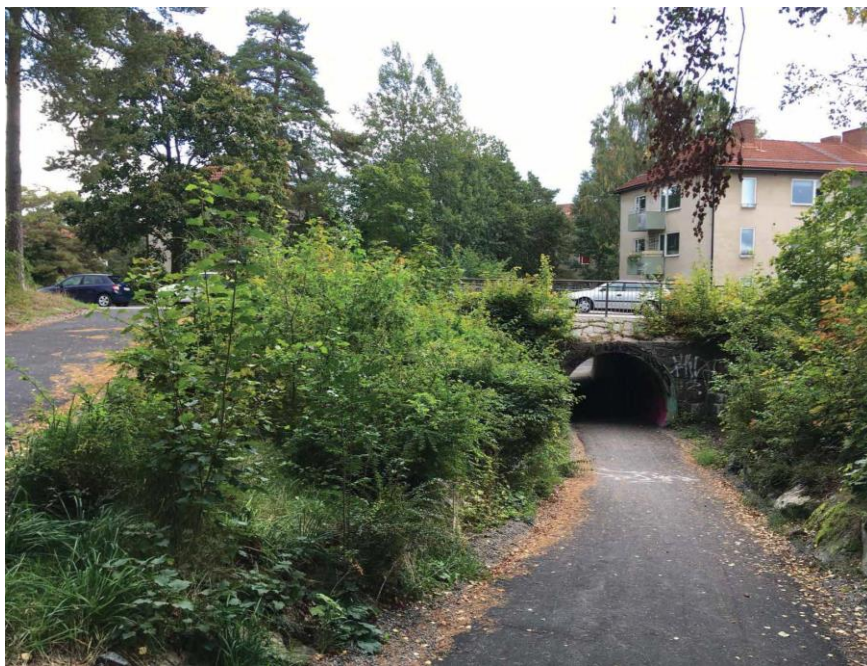
Rusthållarvägen med gång- och cykeltunnel, områdets östra del
