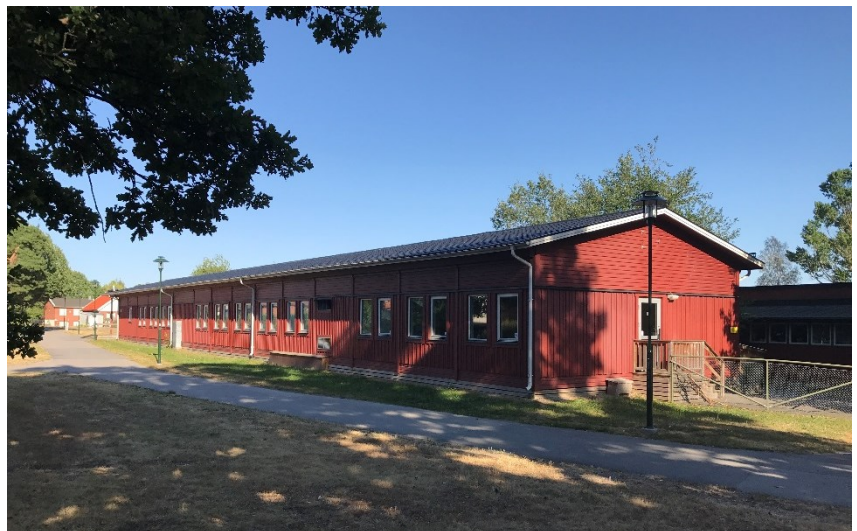
Befintlig paviljong. Sedd från gång och cykelvägen norr om planområdet.
