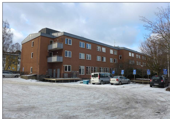
Stödboendet Krinolinen inryms i ett tre våningar högt lamellhus väster om förskolan.
