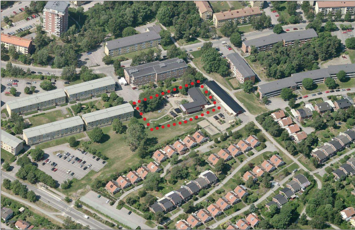
Snedfotografier över fastigheten och dess närmiljö från väster respektive öster. Den befintliga förskolebyggnaden är låg och underordnar sig den högre bebyggelsen i söder och väst. Öster om förskolan ligger ett småhusområde. Bing maps.
