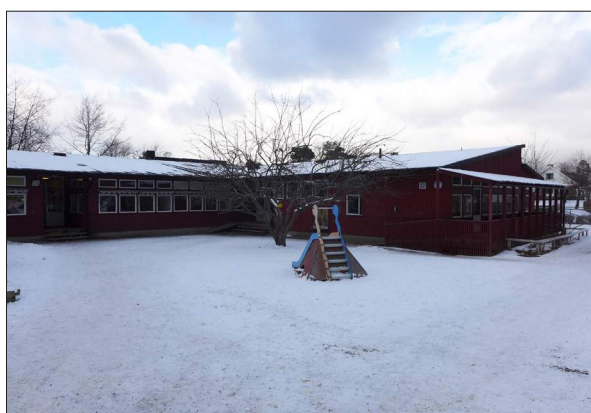
Den äldre förskolebyggnaden är till sin exteriör välbevarad
