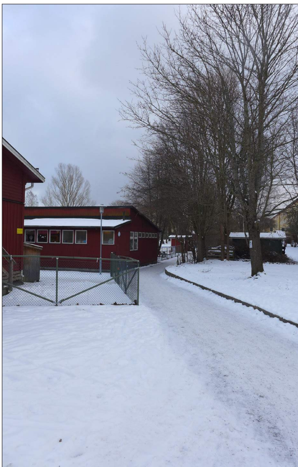
Parkvägens norra ände, i riktning mot förskolan. Den äldre förskolebyggnadens brutna sadeltak i fonden.
