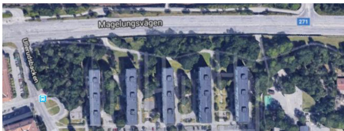
Figur 2. Befintlig bullerskyddsskärm mot Magelungsvägen (Källa: Google maps).
