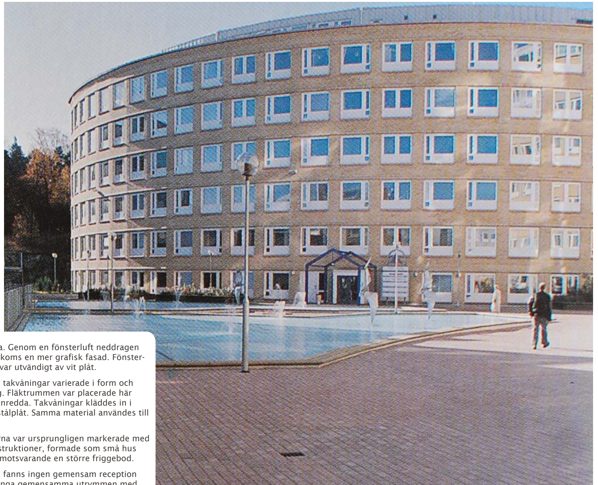
Båghus vid den underbyggda gården som ursprungligen hade öppna vattenspeglar. Observera entrébyggnaden. Foto Tord Lund, i Arkitektur 4/1991.
