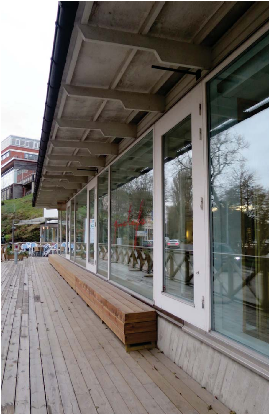
Restaurangens fasad mot vattnet består av betong och glas. Skärmtaket är inte ursprungligt. Trädäcket för uteservering är sentida.
