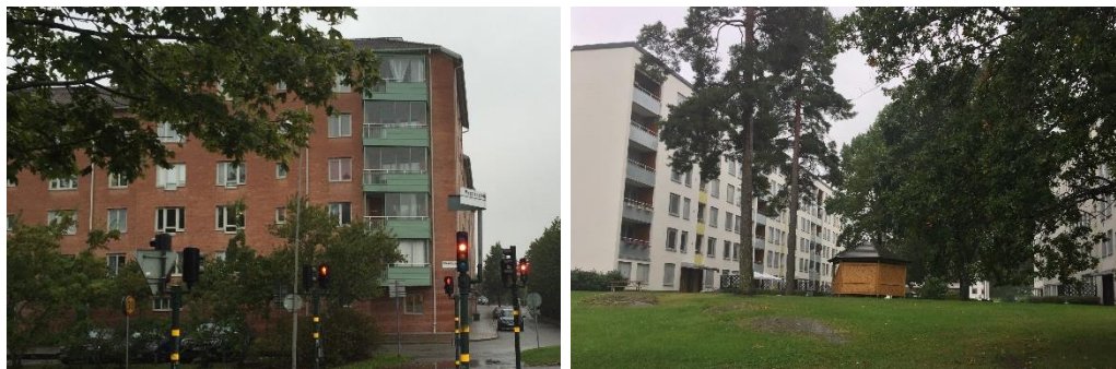
Bild t.v.: flerbostadshus från början av 1990-talet på fastigheten Ängsö 3, placerad vid korsningen mellan Magelungsvägen och Ullerudsbacken. Vy mot väster. Bild t.h.: flerbostadshus från 1960-talet på fastigheten Bjurö 1. Vy mot söder.
