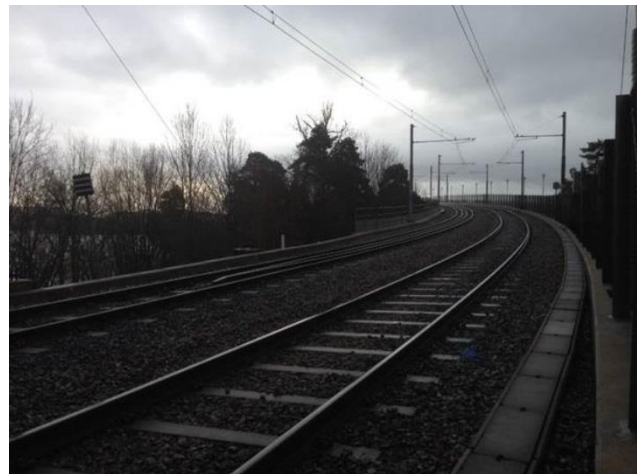
Figur 5. Tvärbanan söder om station Alviks strand. Figur 4. Urspårningsräler längst det vänstra spåret.
