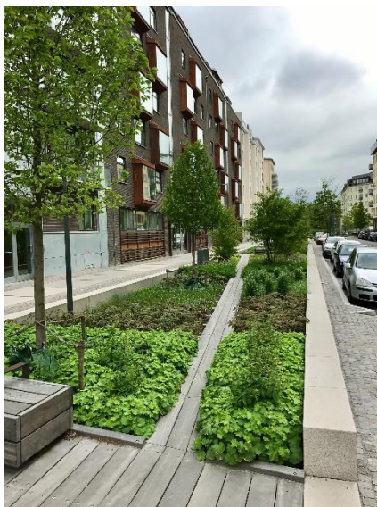
Figur 27. Växtbädd i Norra Djurgårdsstaden, och en sektion där stuprör har utlopp i växtbädden. Foto och skiss: Structor Uppsala AB, 2017.
