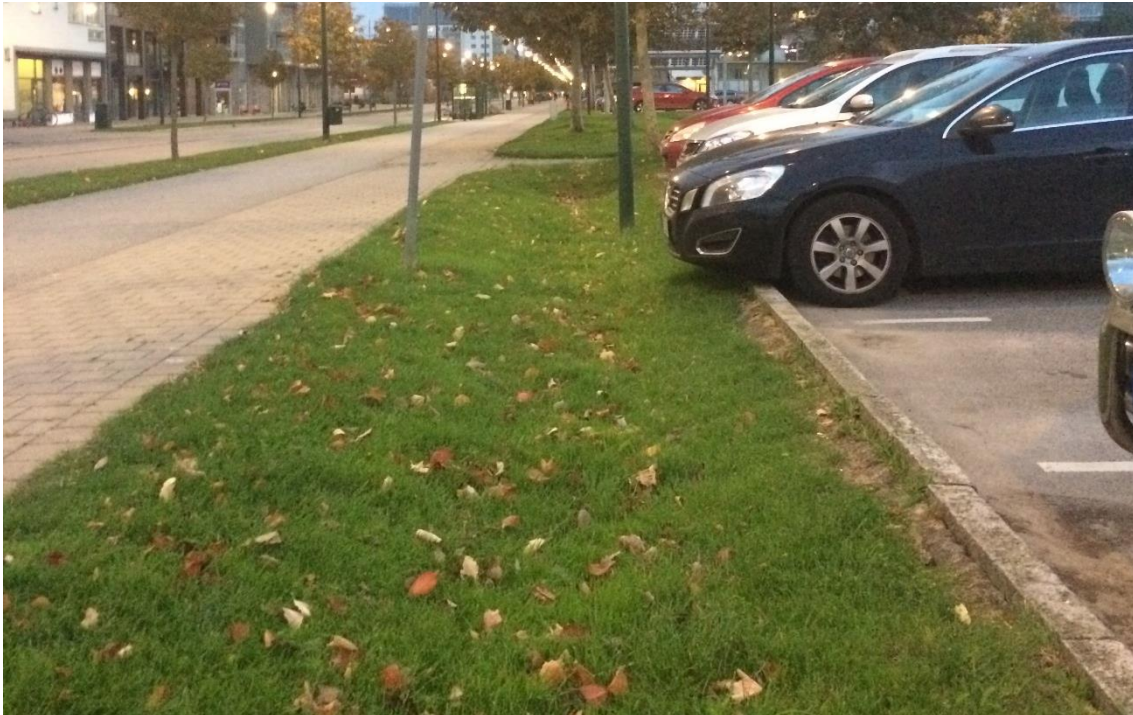
Figur 20. Svackdike mellan parkering och gångbana. Diket bör dock utformas utan kantsten eller med släpp med jämna mellanrum för att dagvattnet ska kunna rinna dit. Foto av Structor Uppsala, 2017.
