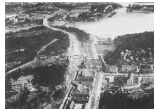
Drottningholmsvägen under uppförande, 1933. Stockholmskällan
