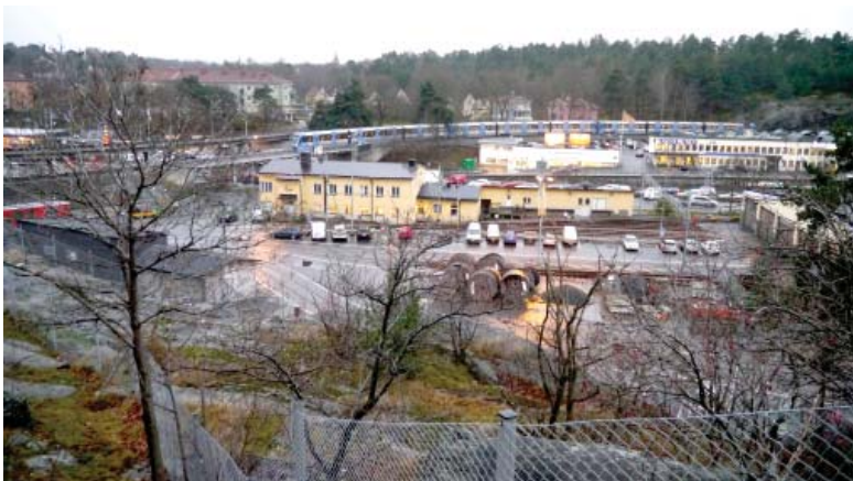
Den öst-västliga dalgången har lång kontinuitet som transportstråk. Många anläggningar och byggnadsverk är också kopplade till transportinfrastruktur.
