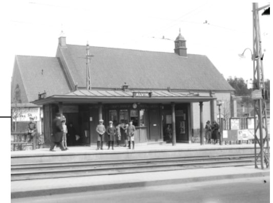
Spårväghållplats Alvik, 1931 Källa: Stockholmskällan
