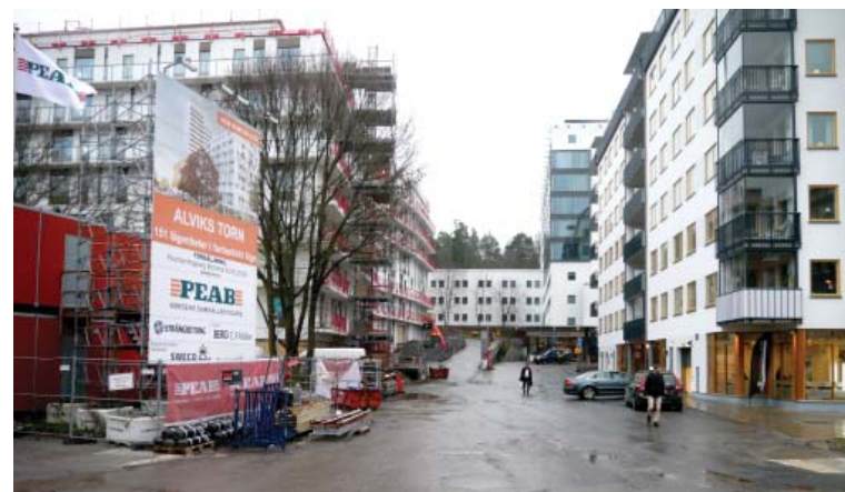
Alvik, en plats i ständig förändring. Alviks torn under uppförande.
