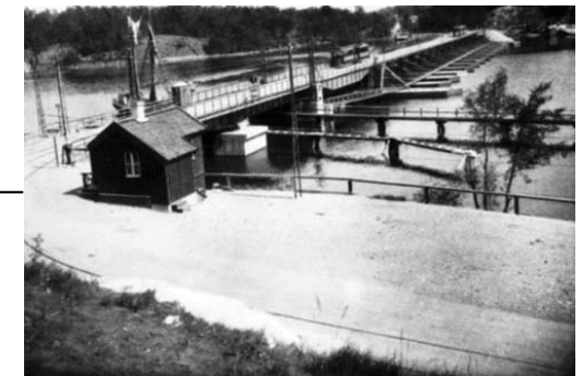
Spårvägsbro på ponton, 1915 Källa: Spårvägmuseet
