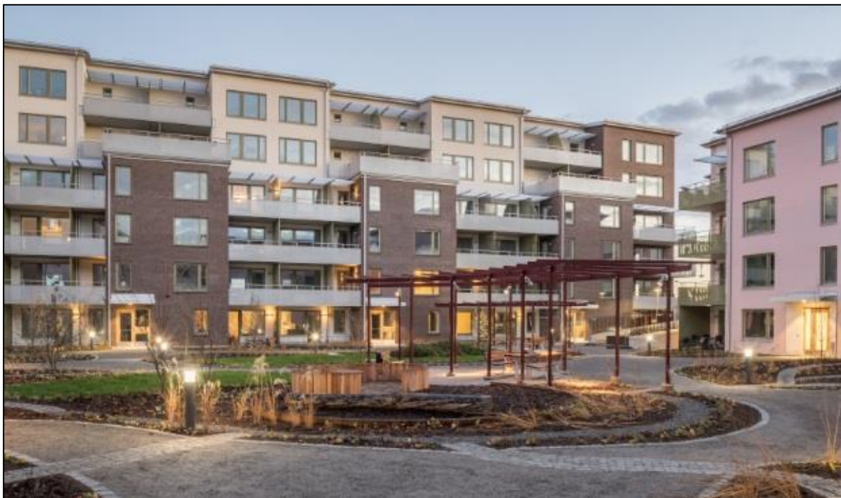
Figur 5–1. Avledning av takvatten till planteringar via rännदार anlagda i gatsten. Exempelbild från Linnéhuset i Uppsala (Källa: Uppsalahem).
