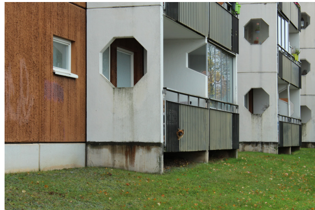
Balkongraderna står till synes stabilt på marken. De har dekorativt utformade gavlar.
