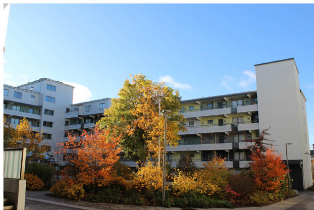
Nyrenoveriad gårdsmiljö. Till vänster ses nybyggnaden som binder samman de båda äldre och ombyggda loftgångshusen
