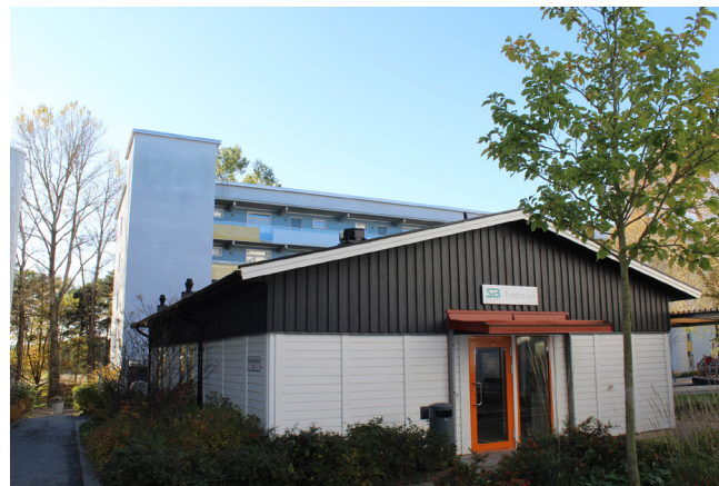
Renoverat gårdshus i kvarteret Molde.
