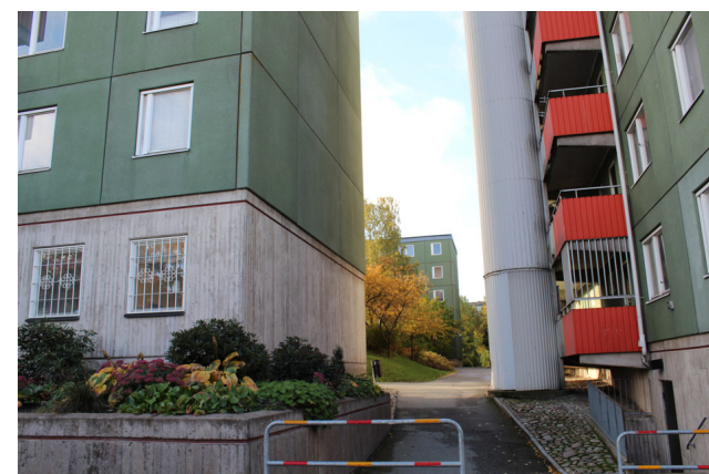
Här ses tydligt fasadestetiken med betongelement och den råa betongen i socklar och murar.
