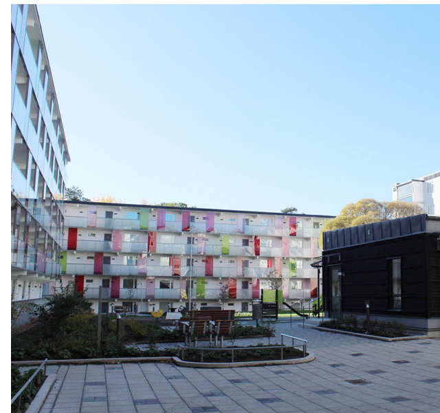
Nyrenoverade fasader och gårdar i kv Molde.
