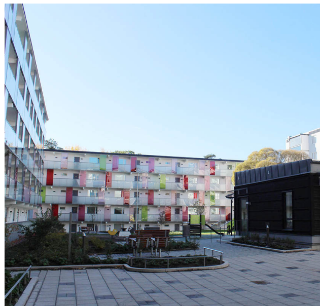
Nedan: Nyrenoverad gårdsmiljö och ombyggda fasader i kvarteret Molde
