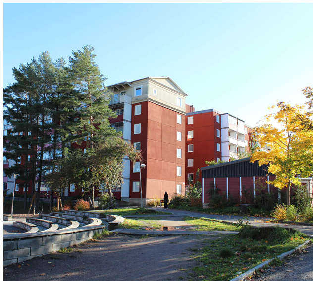
Ovan: Påbyggnad från 1990-talet i kv Oslo.
