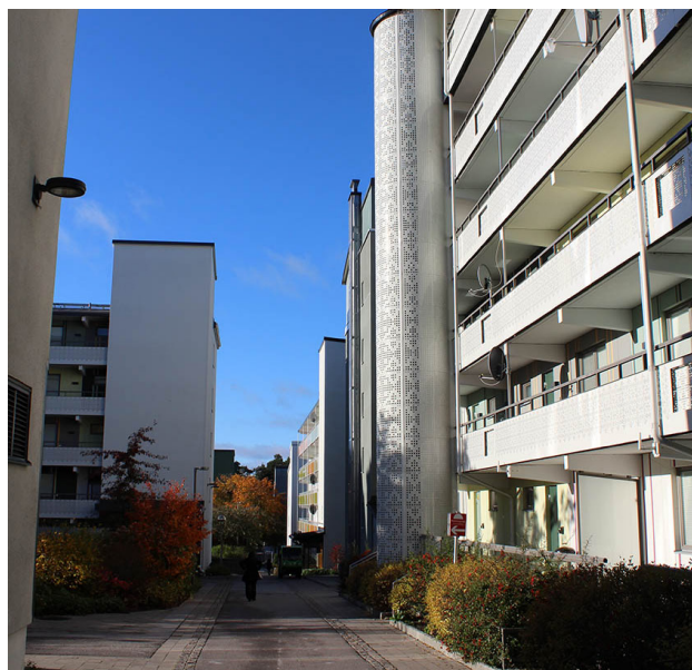
Nedan: Nya räcken till loftgångar och ny inklädnad av utrymnings-trappan med mönsterperforerad plåt. Kv Trondheim.
