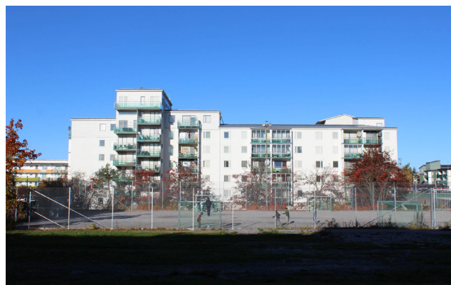
Nybyggnaden i kv. Trondheim 4 med en hög byggnadsdel som binder ihop två äldre hus. Det gamla loftgångshuset till höger är delvis påbyggt och har nyrenoverade fasader.
