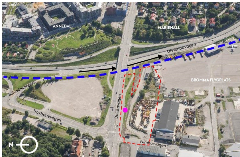
Flygbild från väster med planrådets läge markerat med rött. Befintlig busshållplats markerad med lila cirkel. Tvärbanans planerade sträckning markeras med blå streckad linje och planerade på- och avfartsramper från Ulvsundavägen markeras med svarta pilar.
