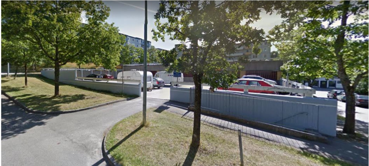
Södra parkeringsdäcket. Foto Google Maps. Foto mot öster.
