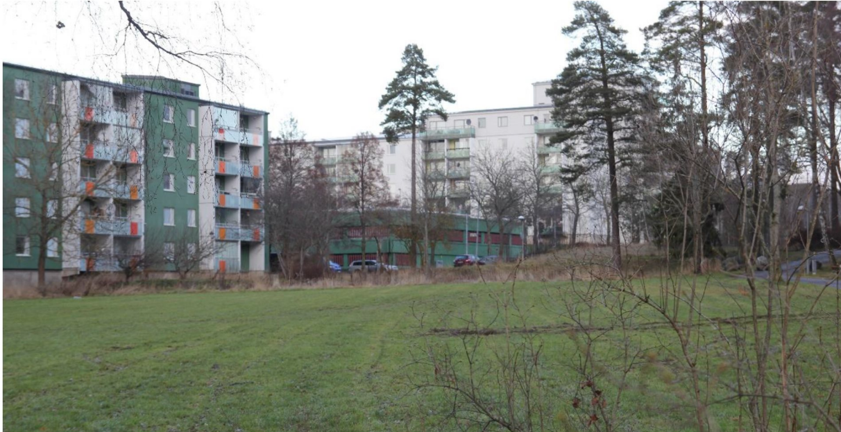
Det södra parkeringsdäcket fotograferat från grönområdet i söder.
