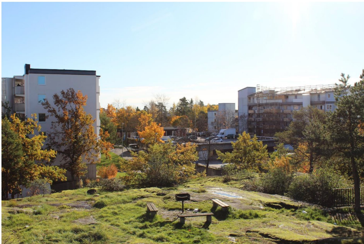
Utsikt från Husbyparken över det norra parkeringsdäcket, med övre däck i två nivåer.
