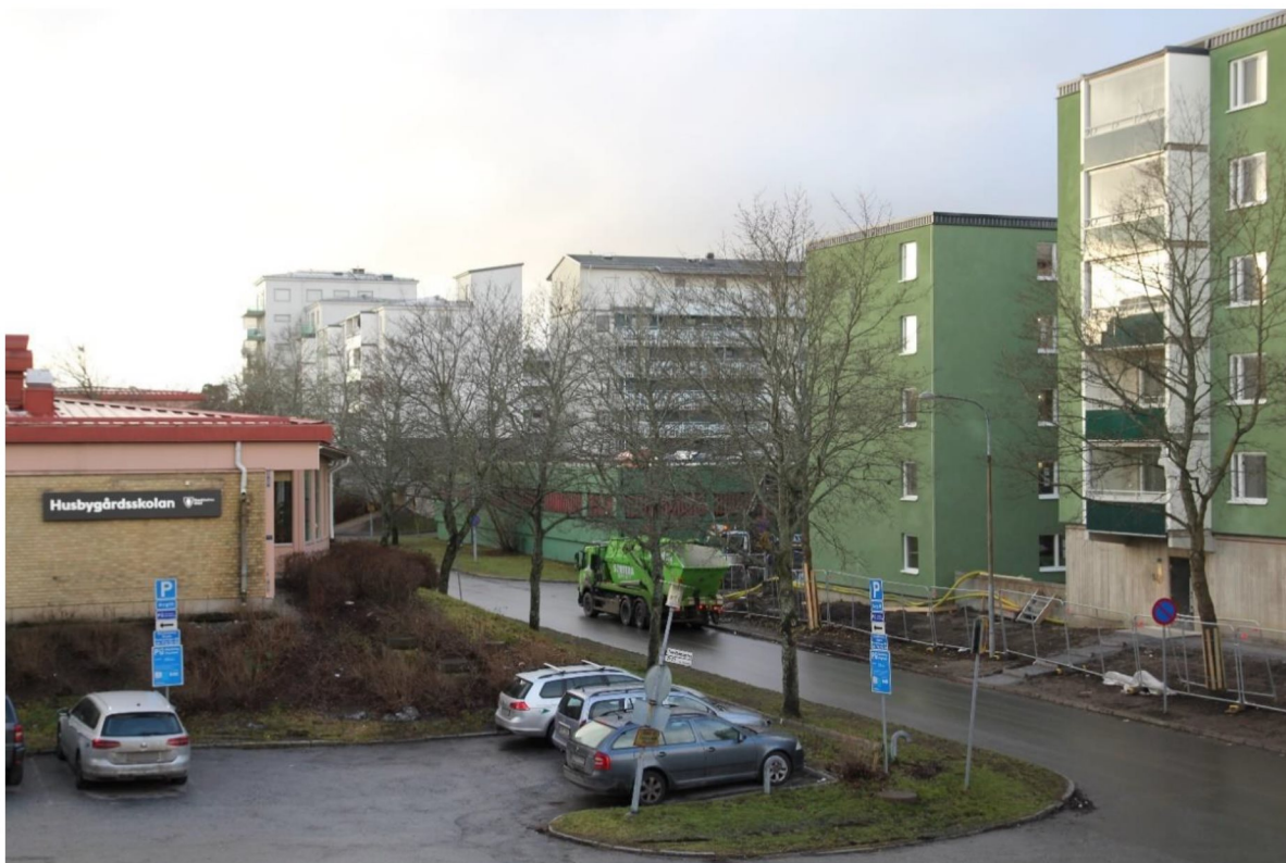
I bildens mitt syns det norra parkeringsdäcket, som ligger mitt emot Husbygårdsskolan F-6. De ljusa husen i bakgrunden är om- och påbyggda. En påbyggnad på parkeringsdäcket kommer göra stadsbilden tätare.
