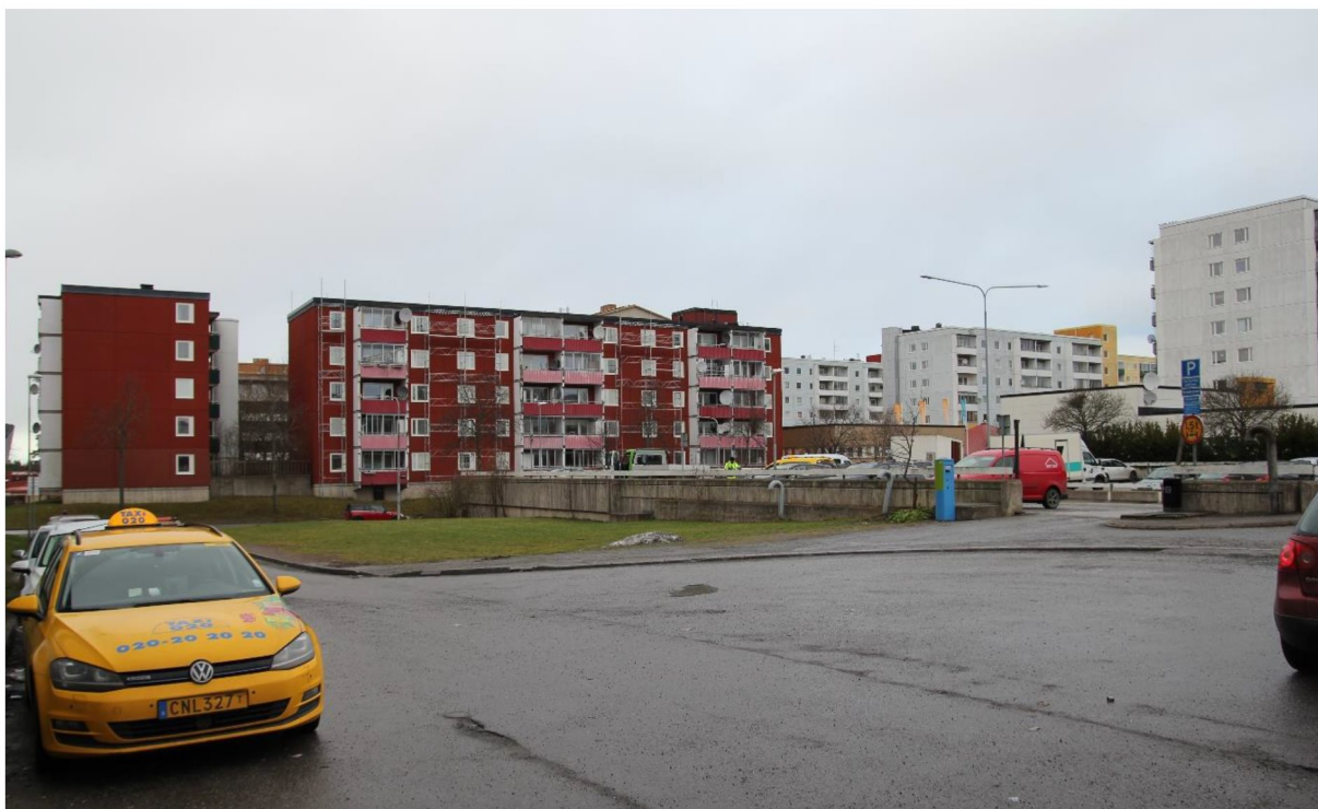
Det östra parkeringsdäcket ligger nära centrum. Foto från återvändsgata.
