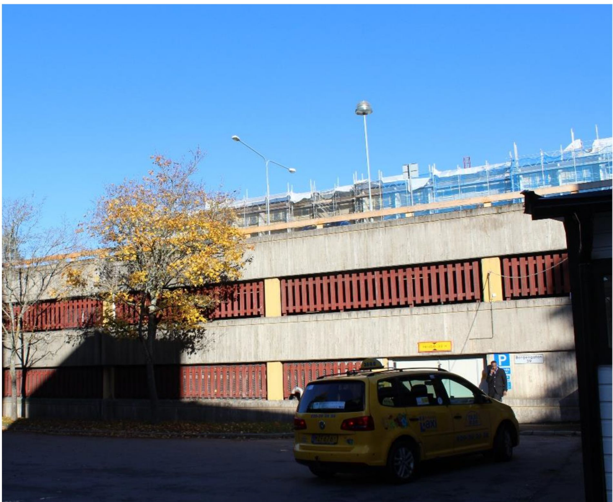
Södra parkeringsdäcket. Foto mot norr.
