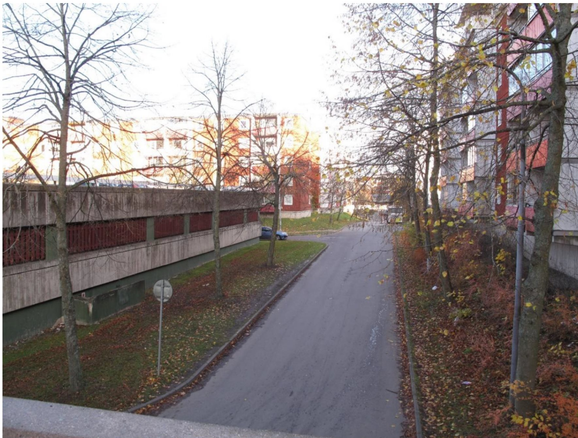
Det västra parkeringsdäcket. Foto från gångbro över Oslogatan mot nordost.
