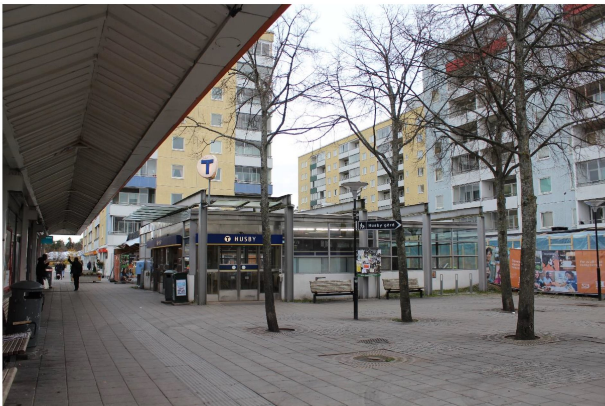
Den befintliga tunnelbanehallen.
