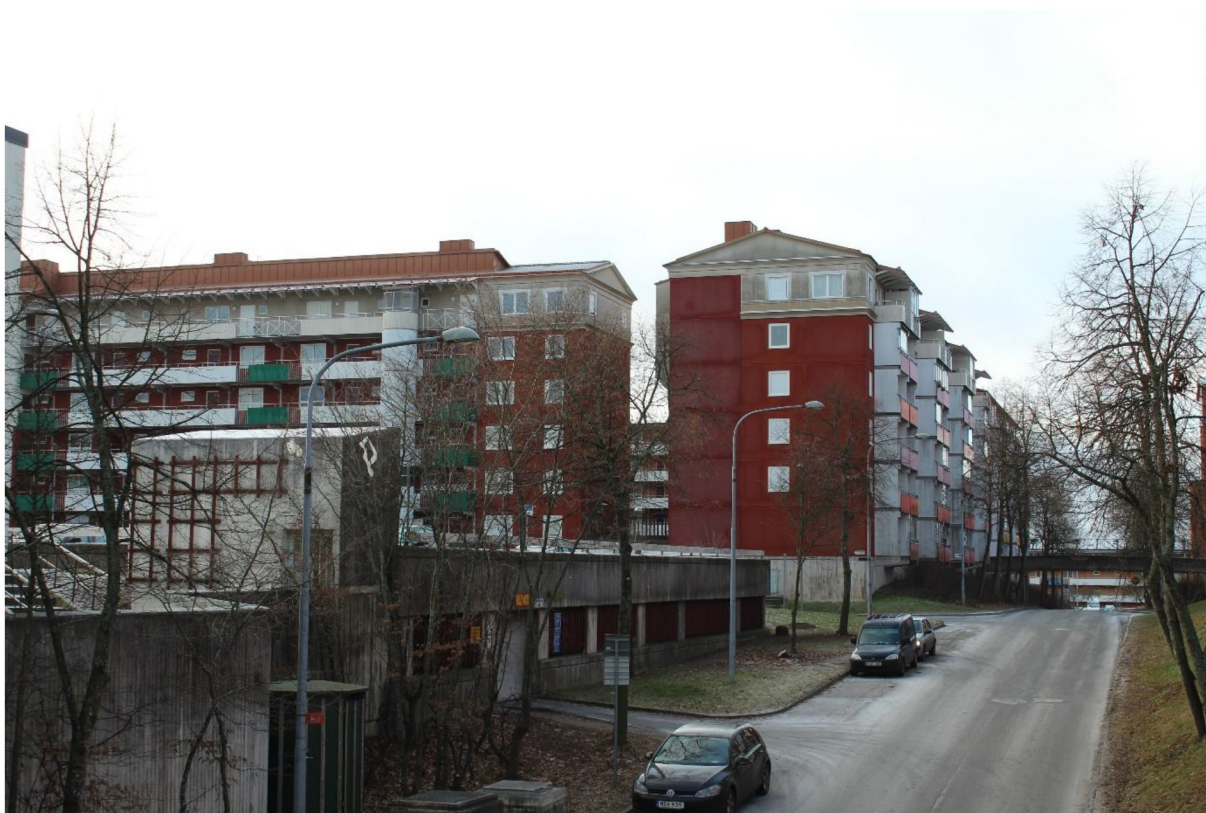
Östra parkeringsdäcket. Foto mot sydväst.
