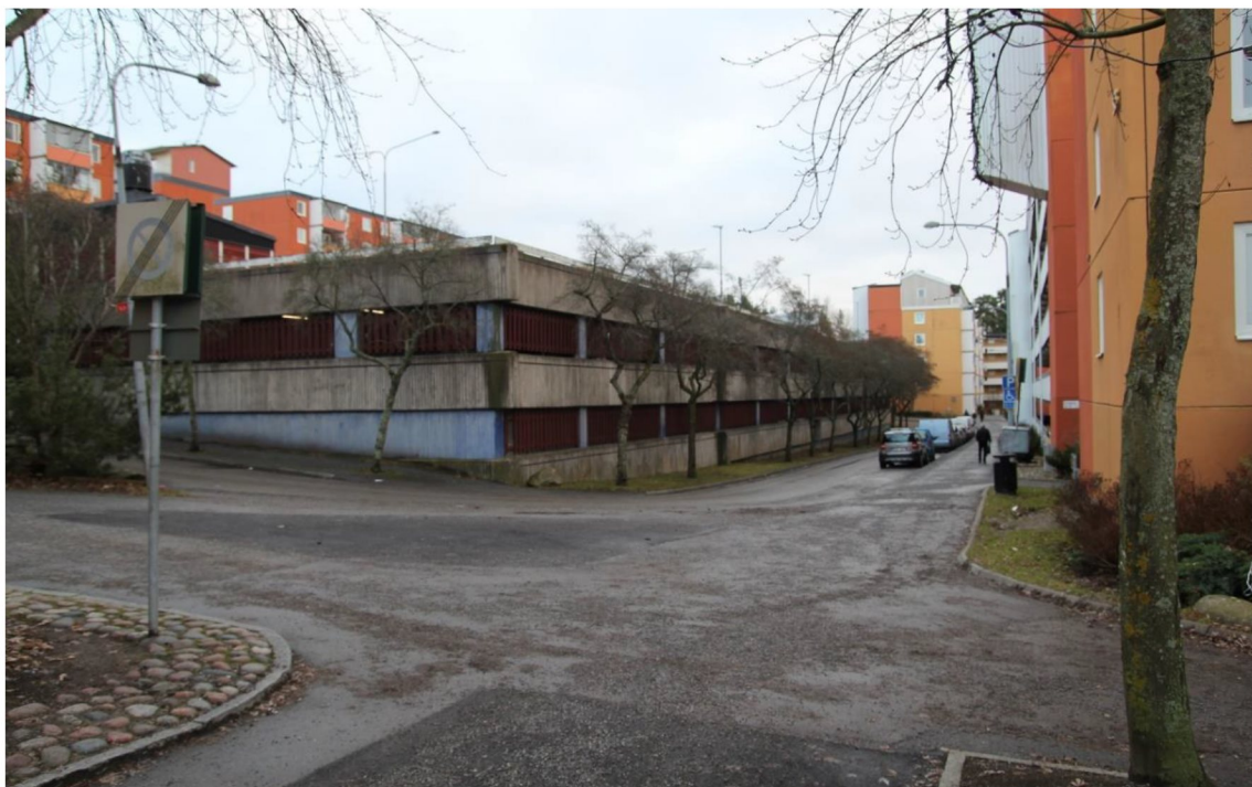
Oslogatan omsluter det tredje parkeringsdäcket (se illustration sid. 12). Detta parkeringsdäck omfattas ej av planerna.
