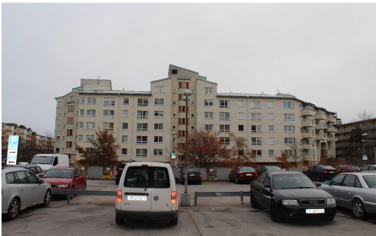
Parkeringsdäcket. Foto mot sydost och kv. Dovre.
