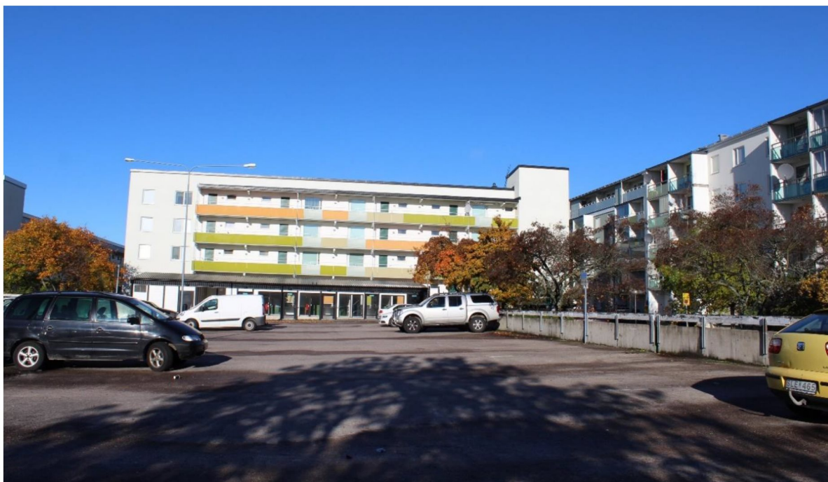
Det södra parkeringsdäcket. Foto mot nordväst.
