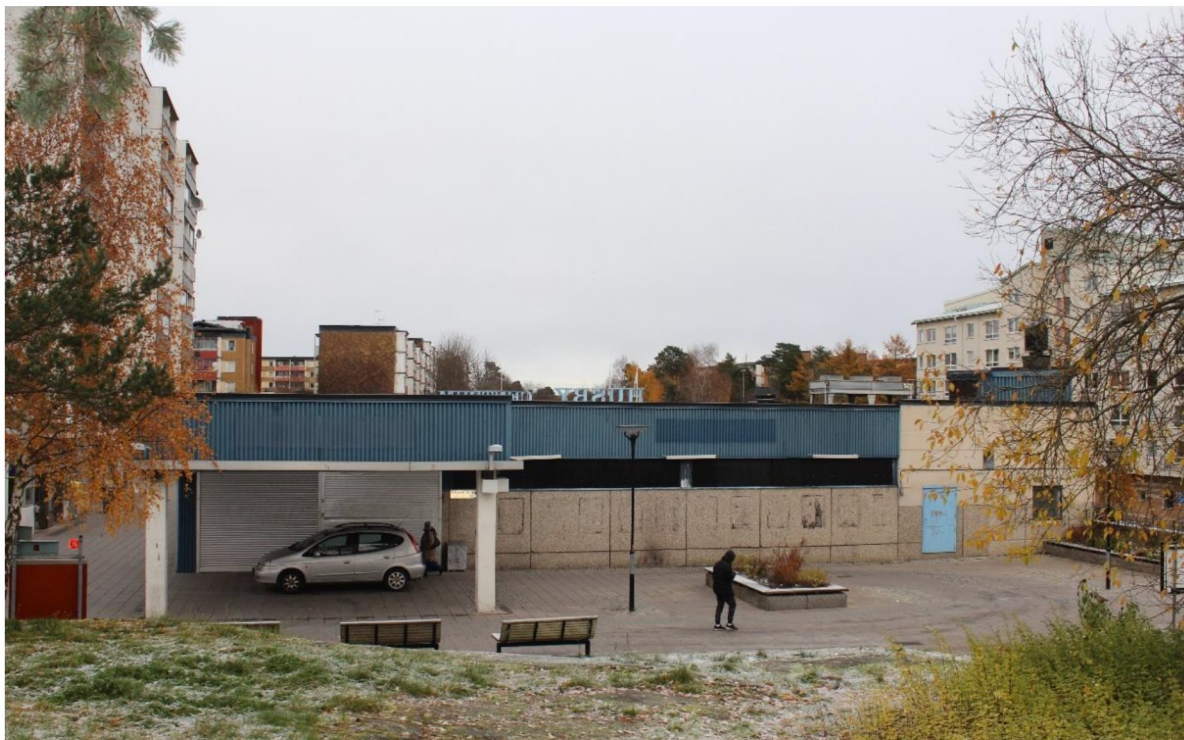
Den tidigare livsmedelshallen. På platsen planeras ett femvåningshus med två trapphus. Foto från Husbyparken mot norr.
