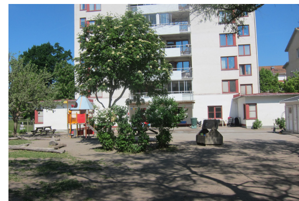
Figur 49. En befintlig bostadsgård i området med lekplats.
