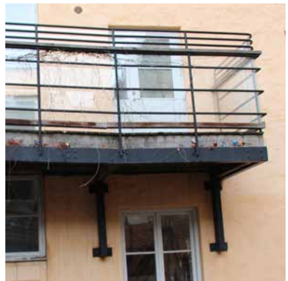
Foto som visar påhängd balkong med koppling till den övre gården, "Terrassen".
