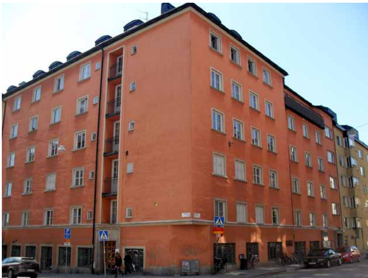
Fastigheten kv Bonden Mindre 14 sedd från Nytorngsgatan/Bondegatan. Här ligger byggnaden i soutteräng.
