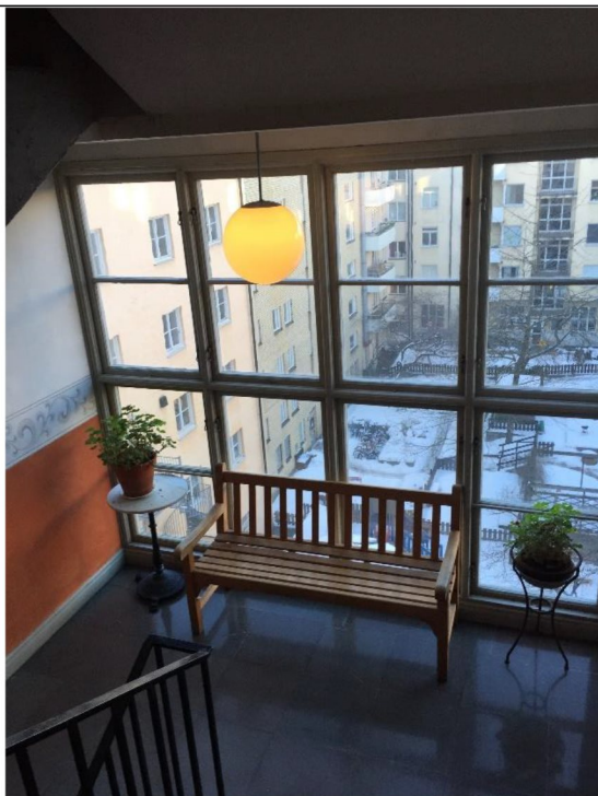
Brännbart material i utrymningstrapphus
