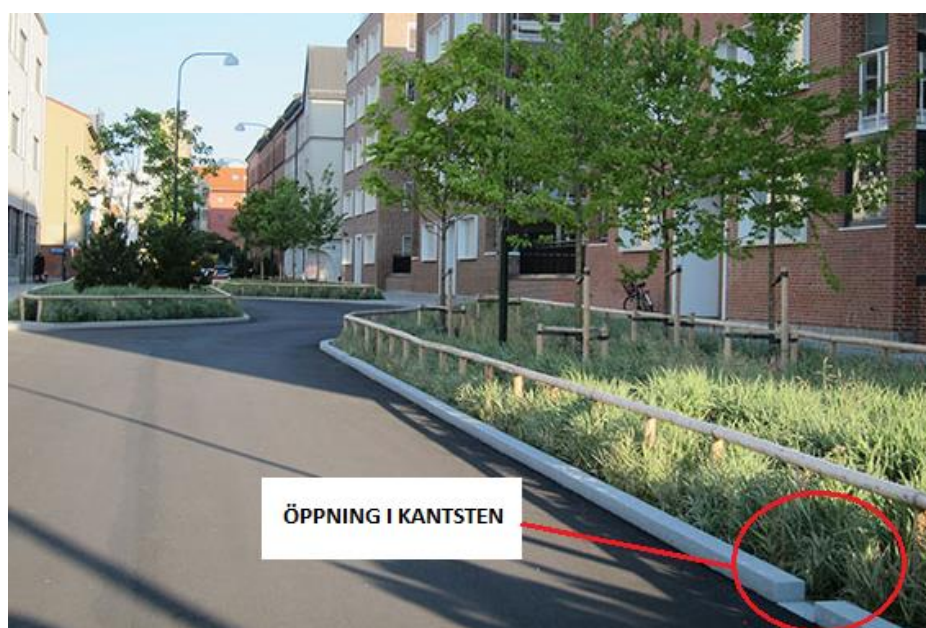
Figur 9. Exempelbild på nedsänkt växtbädd med öppning i kantsten.
